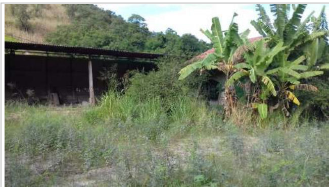
VISTA INTERNA (LOTE 71)
