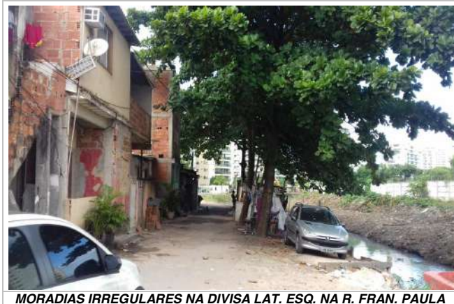
MORADIAS IRREGULARES NA DIVISA LAT. ESQ. NA R. FRAN. PAULA
