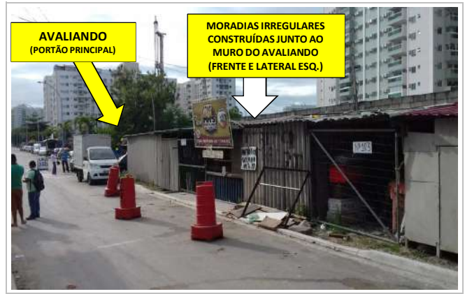
VISTA FRENTE DO AVALIANDO E MORADIAS IRREGULARES
