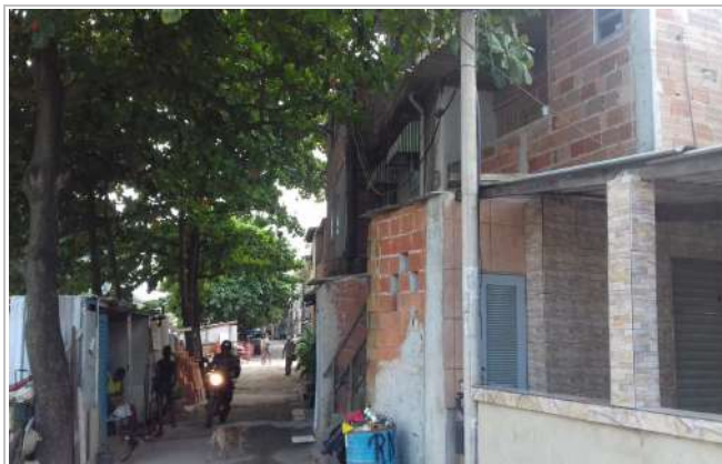
MORADIAS IRREGULARES NA DIVISA LAT. ESQ. NA R. FRAN. PAULA
