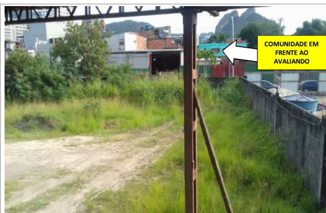
VISTA INTERNA (MURO / VIZINHO DIREITA C/ CONSTRUÍDO TORRES RESID.)
