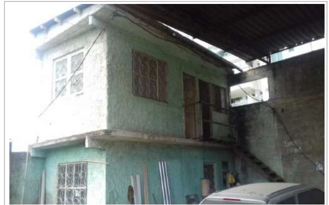
VISTA EDIFICAÇÃO JUNTO AO GALPÃO (DIVISA FUNDOS)
