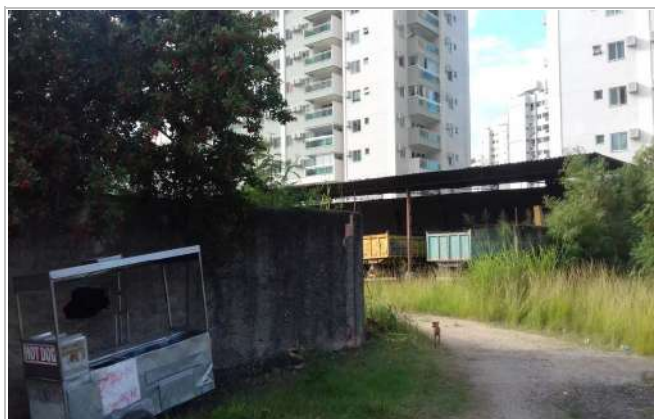
VISTA INTERNA AVALIANDO
