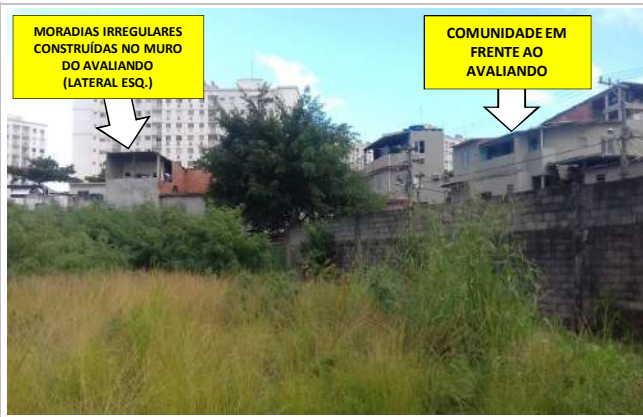
VISTA INTERNA (MORADIAS IRREGULARES NO MURO DA FRENTE E LATERAL)
