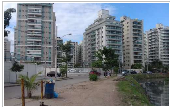
VISTA R. FRAN. PAULA (FUNDOS AVALIANDO / TRECHO APÓS MORADIAS IRREGULARES)
