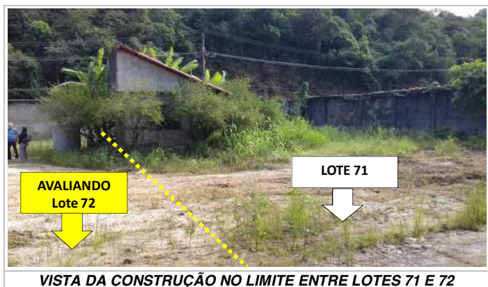
VISTA DA CONSTRUÇÃO NO LIMITE ENTRE LOTES 71 E 72
