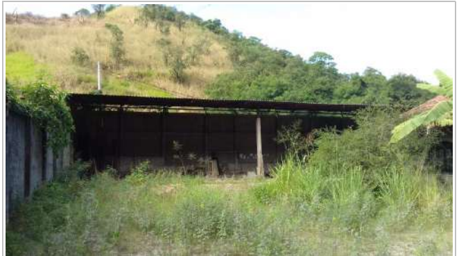
VISTA INTERNA (LOTE 71)
