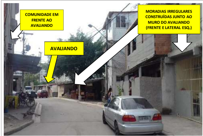
VISTA DA RUA DO AVALIANDO ESQUINA C/ R. FRANCISCO DE PAULA
