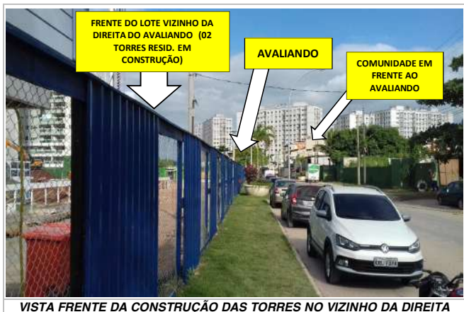
VISTA FRENTE DA CONSTRUÇÃO DAS TORRES NO VIZINHO DA DIREITA
