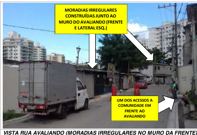
VISTA RUA AVALIANDO (MORADIAS IRREGULARES NO MURO DA FRENTE)
