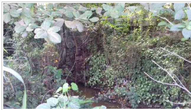
VISTA CÔRREGO COMUM AOS TERRENOS
