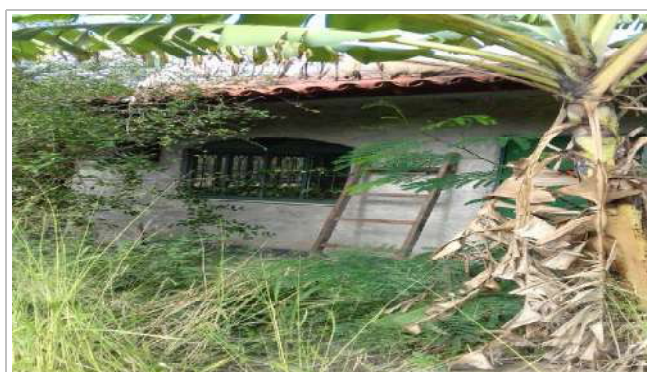
VISTA CONSTRUÇÃO NO LOTE 71
