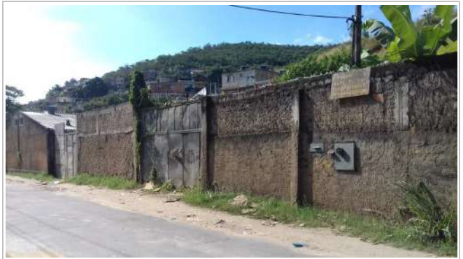
VISTA PORTÃO DA FRENTE (LOTE 71)
