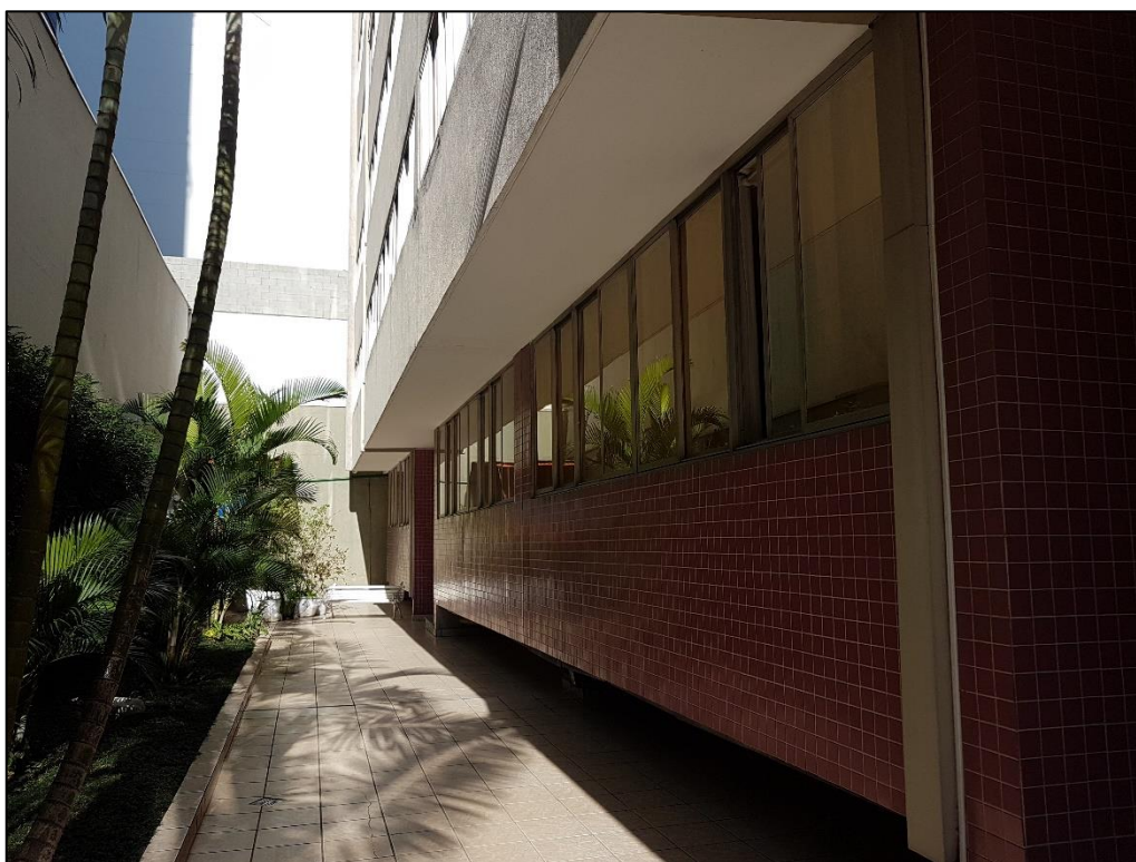
Imagem 14: Corredor de acesso aos Blocos
