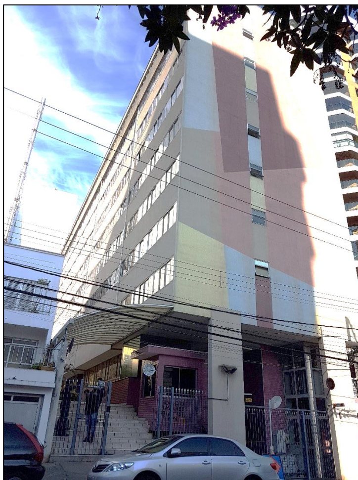
Imagem 12: Vista da fachada do Edifício Tavares Bastos
