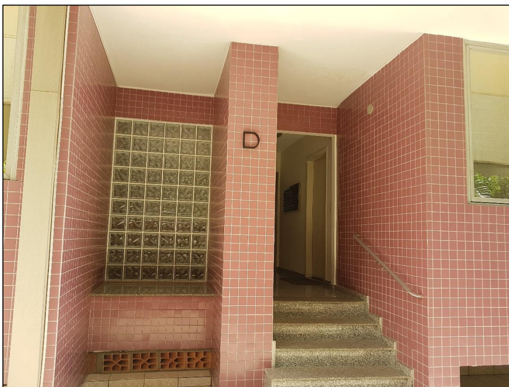
Imagem 16: Entrada do Bloco "D"
