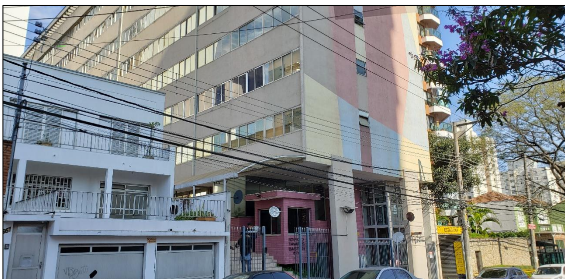
Imagem 13: Vista da fachada do Edifício Tavares Bastos
