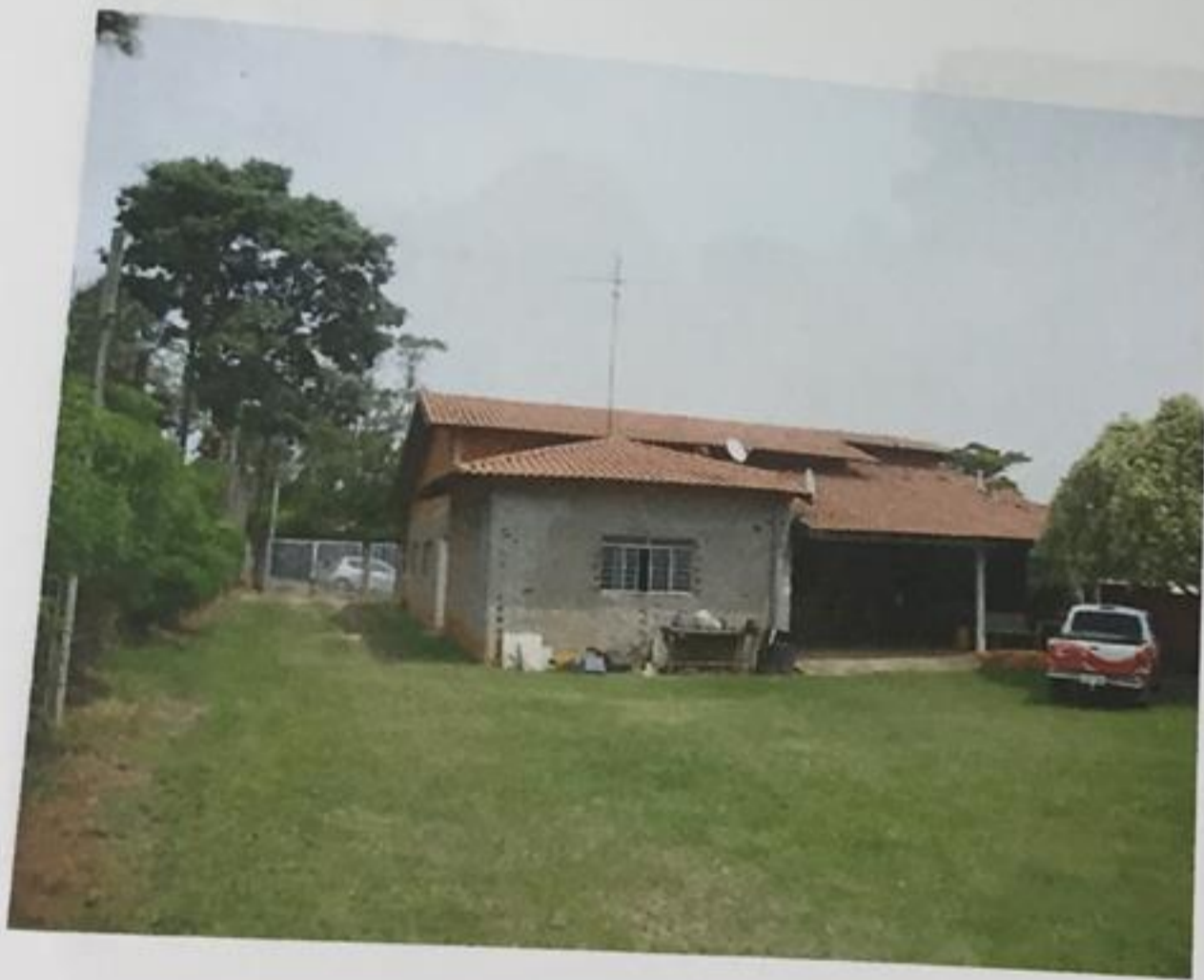
Foto n° 18 - Fundos da casa da frente
