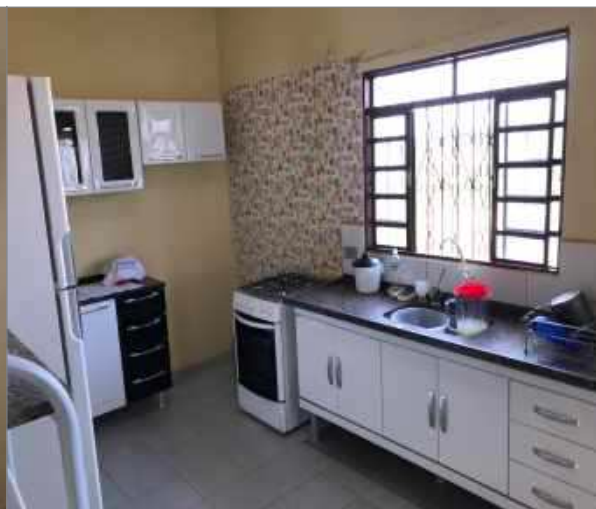
Imagem 12 – Tomada fotográfica ilustrando cozinha. Detalhe para azulejos somente na parede hidráulica.
