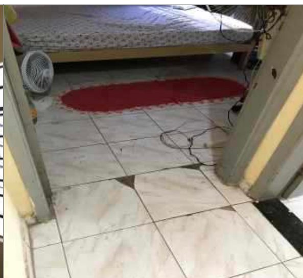
Imagem 08 – Ilustra piso cerâmico encontrado no interior da edificação e estado de conservação.
