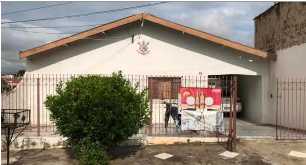
Imagem 04 – Tomada fotográfica obtida da Rua Cedral, ilustrando frente do imóvel II para esta via.
