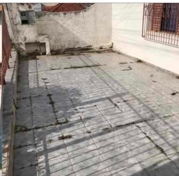
Imagem 06 – Vista parcial do recuo frontal, ilustrando piso cerâmico comum e estado de conservação.
