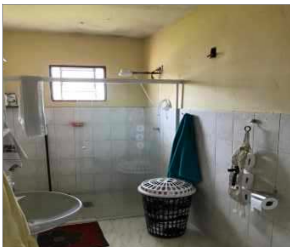
Imagem 09 – Banheiro possui peças sanitárias comuns e metais de modelo simples. detalhe para azulejo meia altura.
