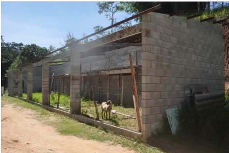
Foto 17: Vista do galpão.
