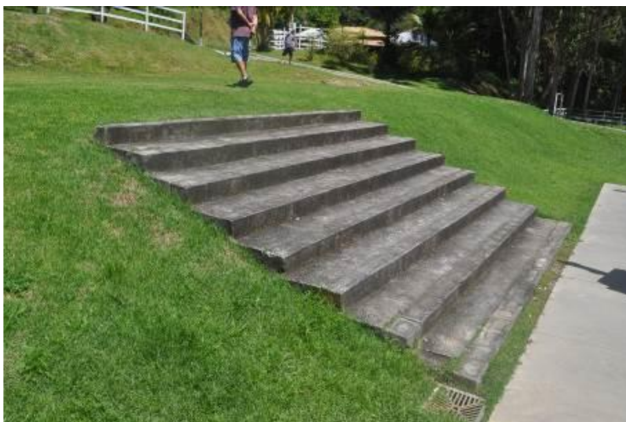
Foto 37: Vista da escada.
