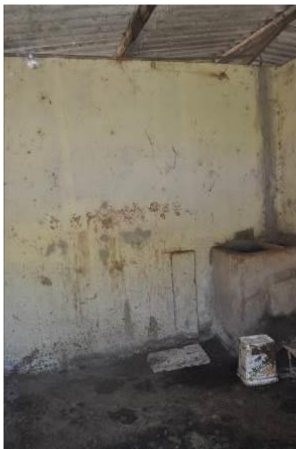
Foto 20: Vista interna da cocheira.
