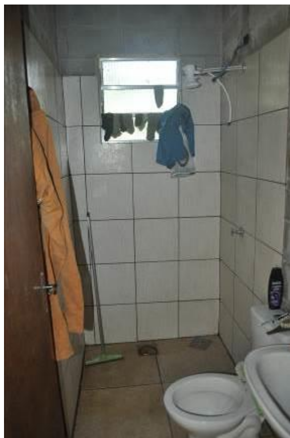
Foto 10: Vista do banheiro casa caseiro I.
