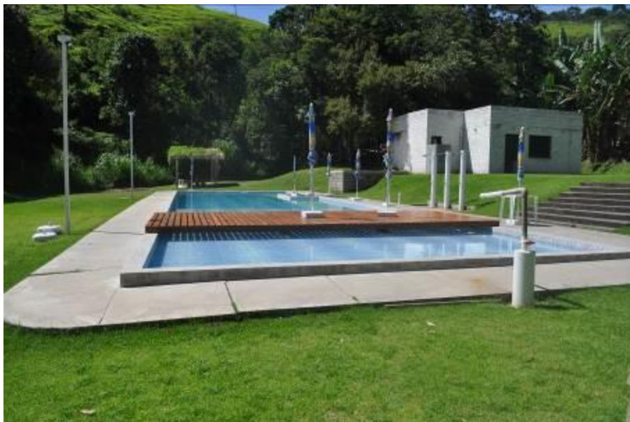
Foto 25: Vista da piscina.
