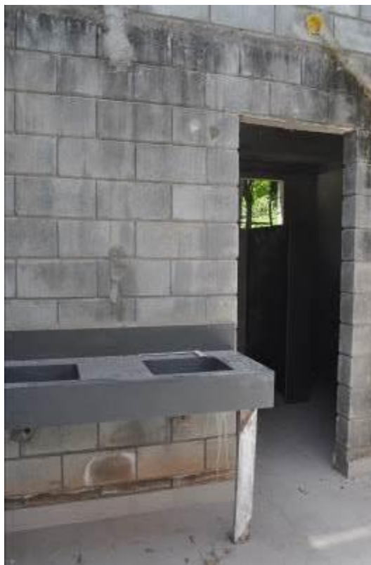
Foto 31: Vista interna do vestiário.
