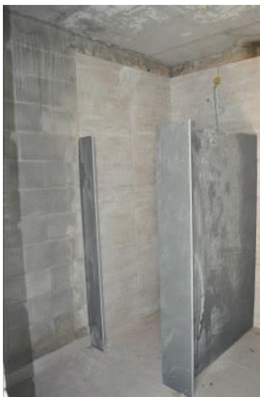
Foto 32: Vista interna do vestiário.
