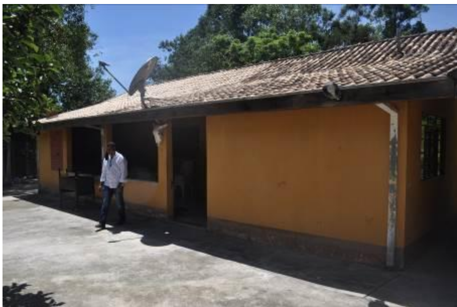
Foto 5: Vista da fachada dos fundos casa sede.
