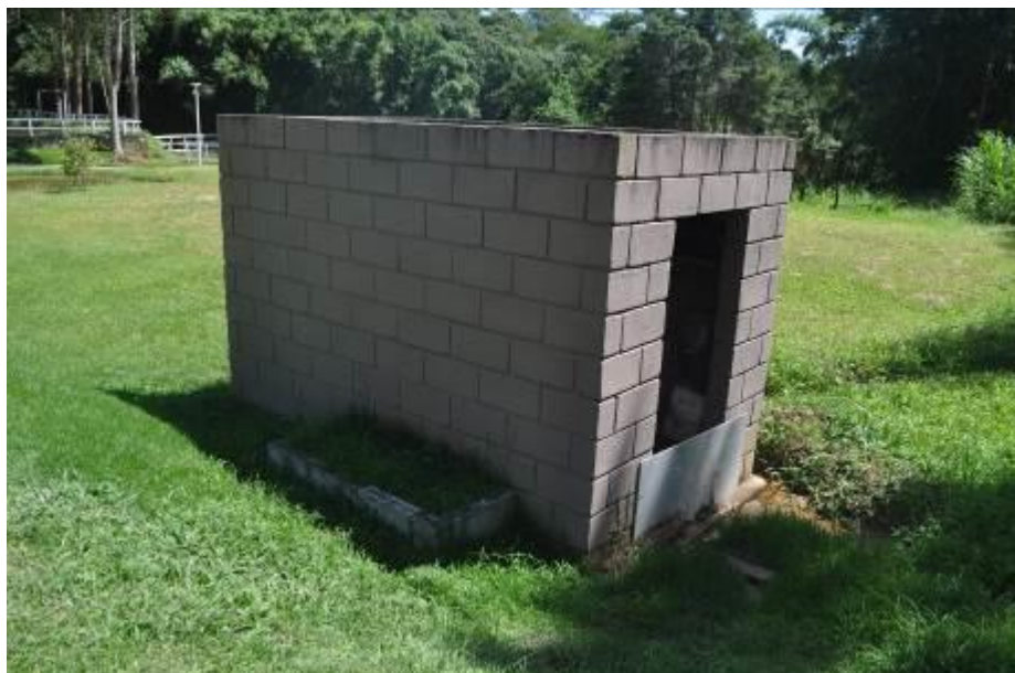
Foto 23: Vista da casa de máquinas.
