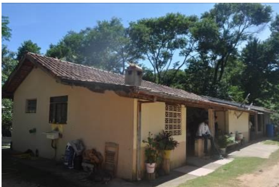
Foto 13: Vista da casa caseiro II.
