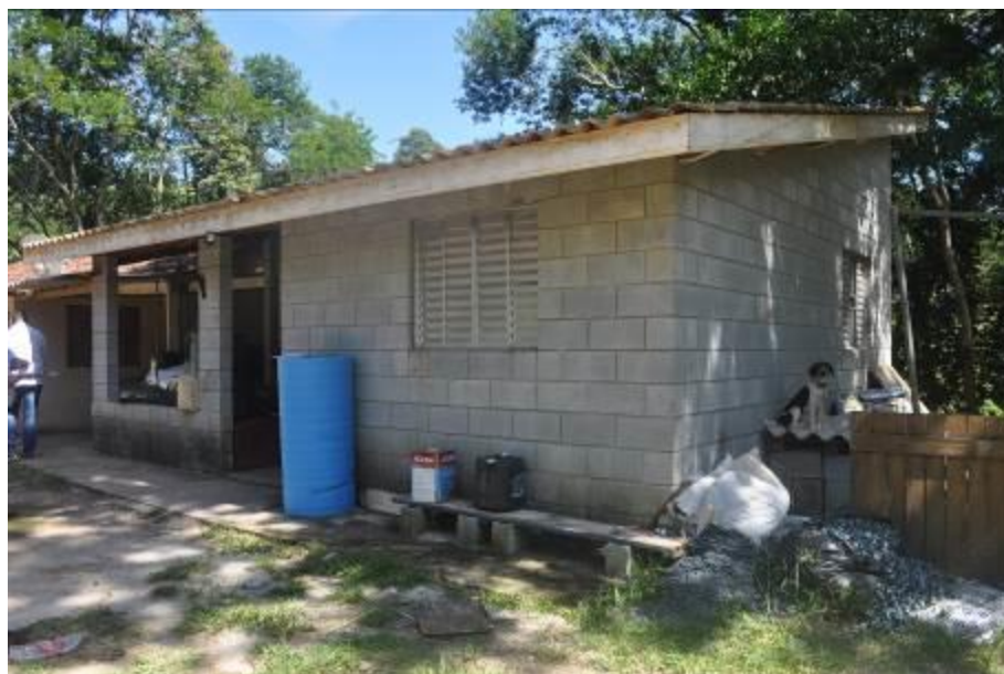
Foto 9: Vista da casa caseiro I.
