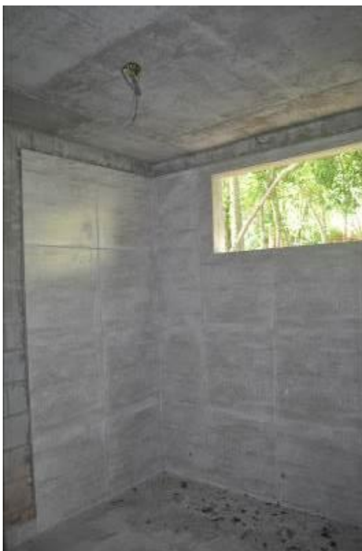
Foto 33: Vista interna do vestiário.
