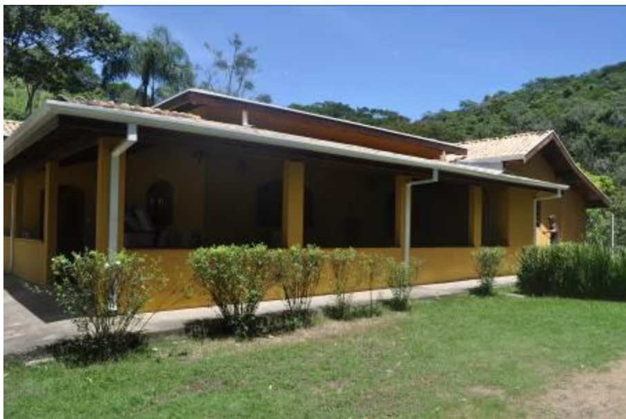
Foto 1: Vista da fachada da casa sede.
