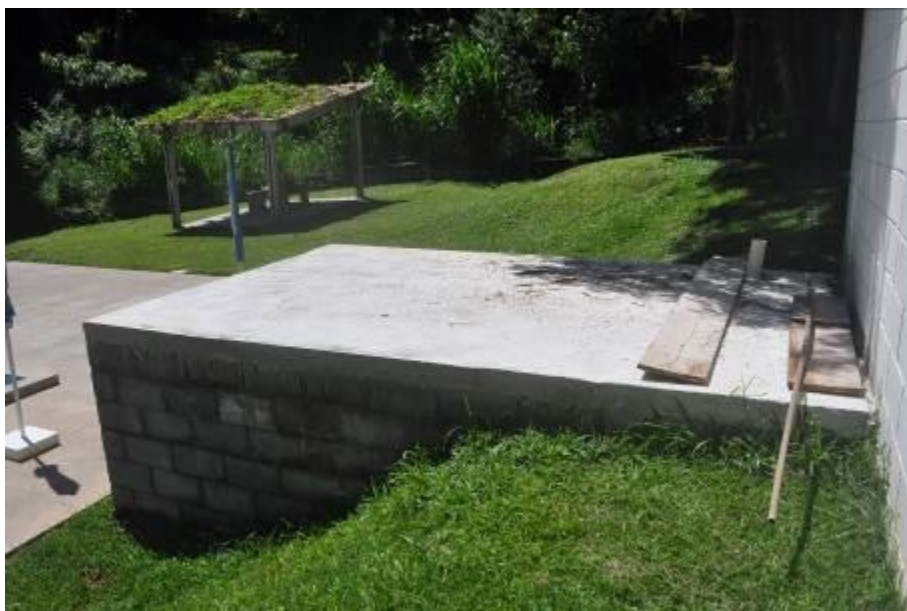
Foto 34: Vista do deck do vestiário.
