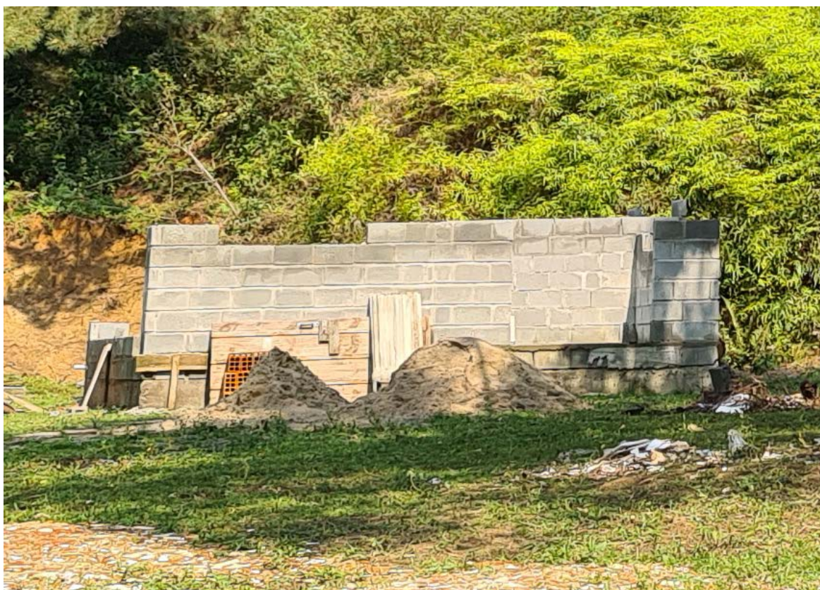
FOTO 12: VISTA DA EDIFICAÇÃO EM CONSTRUÇÃO.
