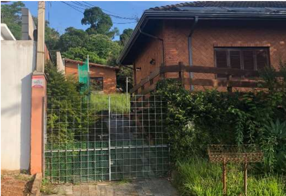
Acesso aos fundos do imóvel
