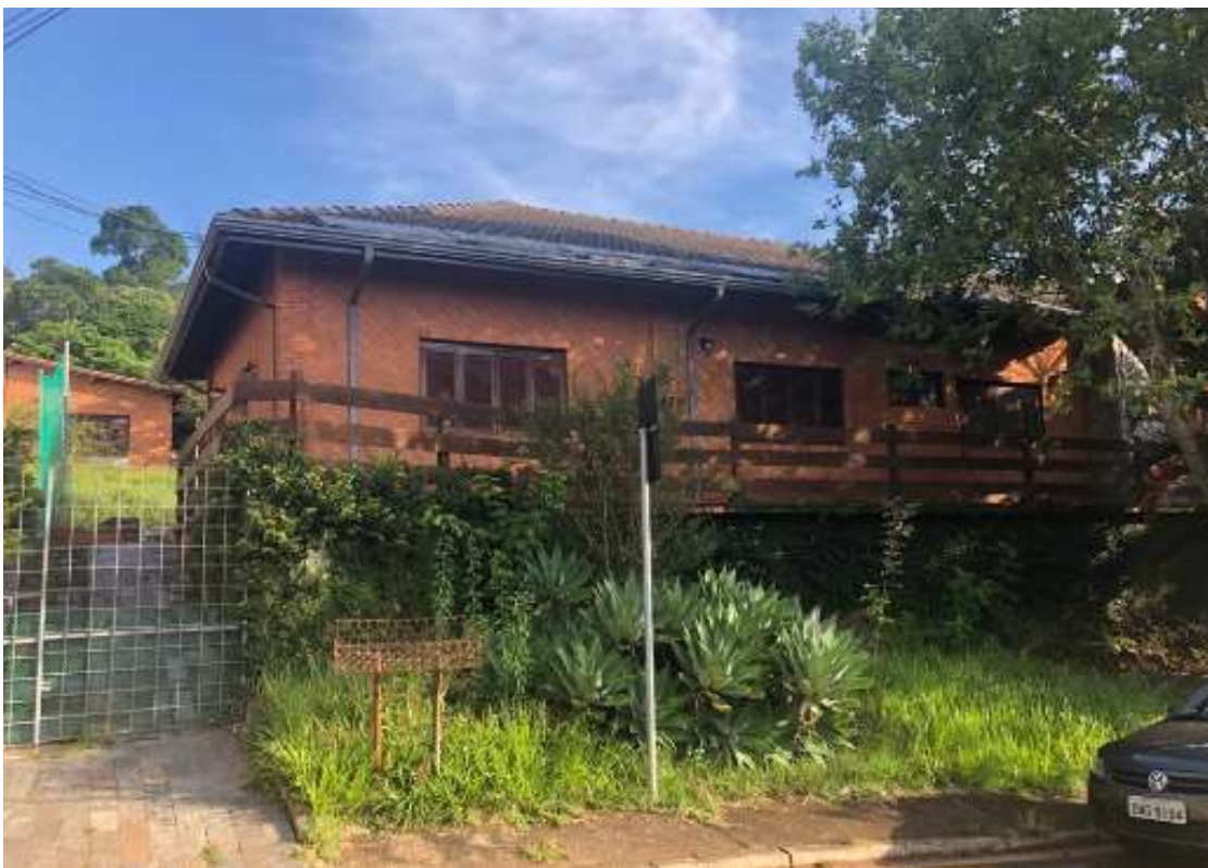
Lateral do imóvel
