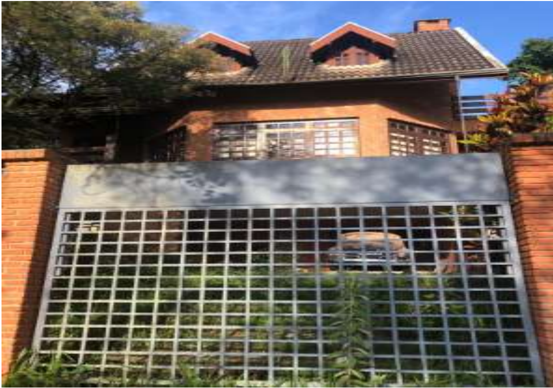
Acesso a garagem coberta
