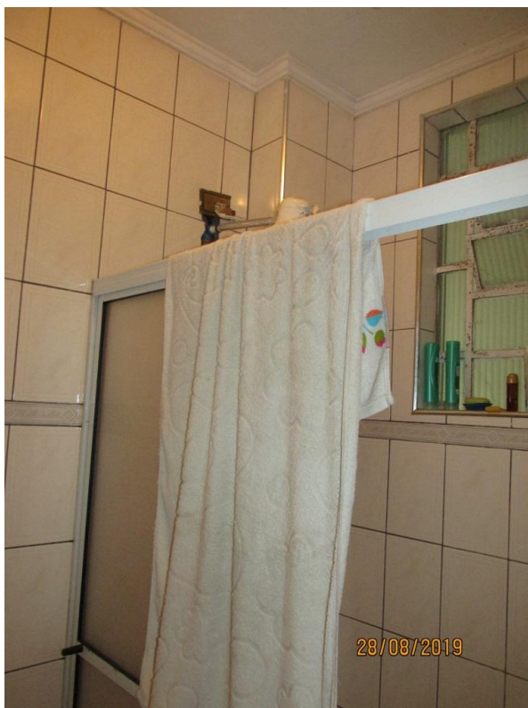
Foto 22 - Banheiro, completo com box para chuveiro
