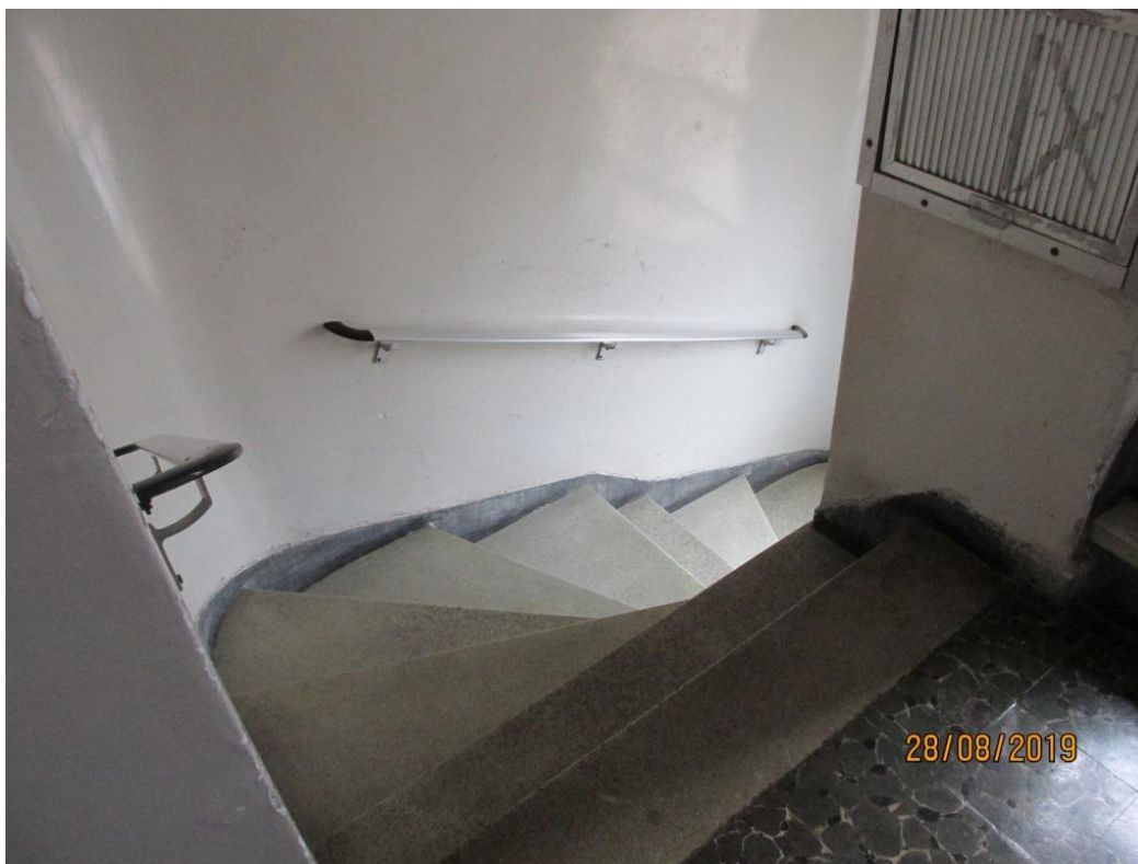
Foto 12 - Detalhe da escadaria tipo – piso granilite e corrimão de alumínio
