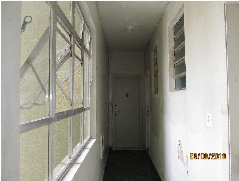
Foto 10 - Circulação interna de acesso as unidades
