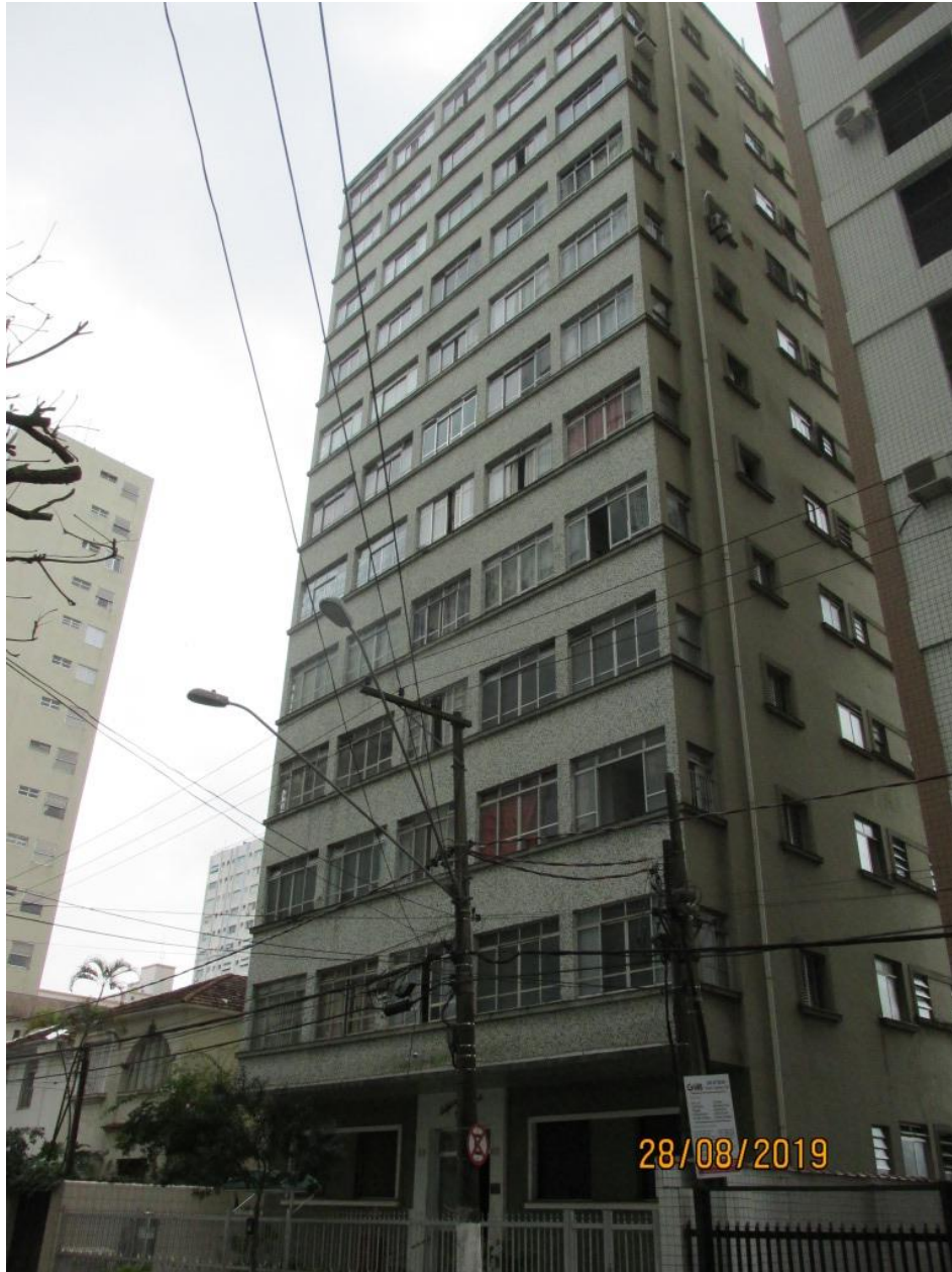
Foto 1 - Fachada do Edifício MAGDALENA
