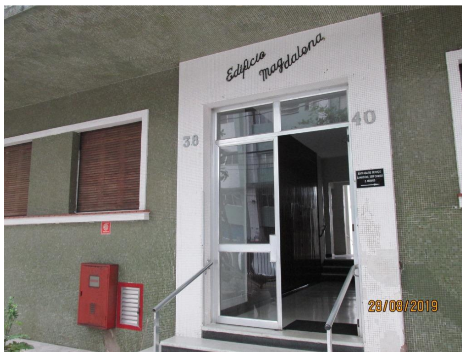
Foto 3 - Entrada social do edifício
