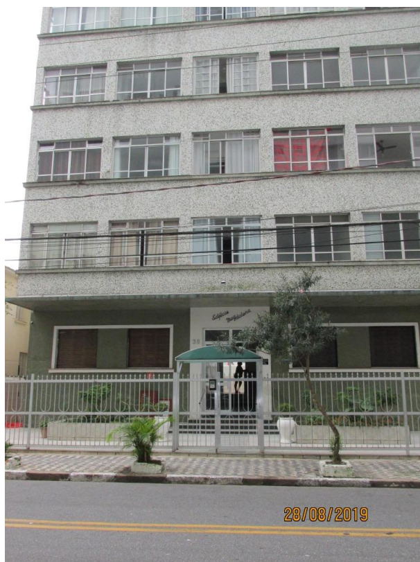
Foto 2 - Detalhe da fachada
