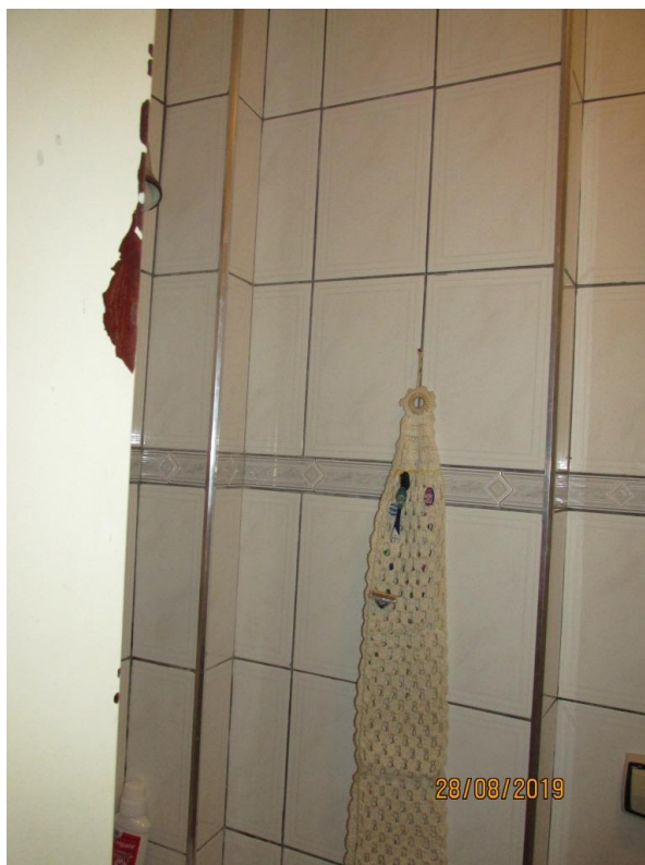
Foto 24 - Detalhe do revestimento do banheiro
