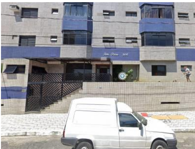
Foto 02 – Vista da fachada do Condomínio Edifício Orion.
