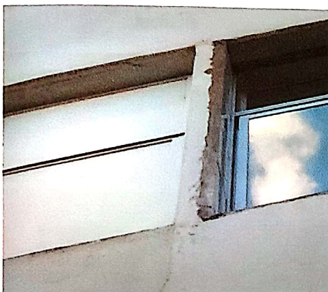
Imagem 48 – detalhe de acabamento para chumbamento em esquadria
