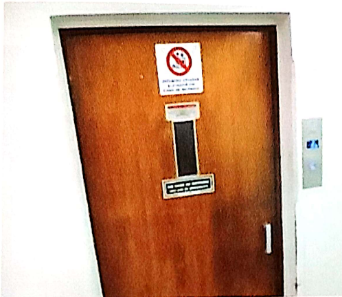
Imagem 42 – porta de elevador
