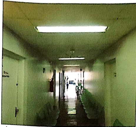
Imagem 27 – corredor do 1º pavimento (salas de consultório)
