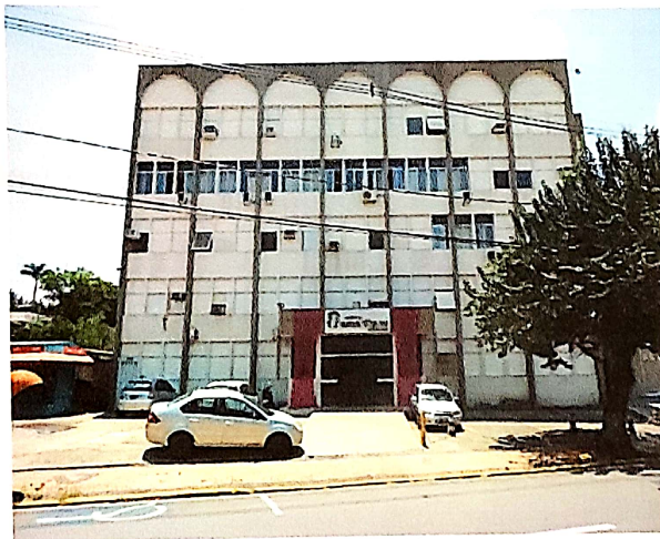
Imagem 01 – detalhe da fachada do prédio
