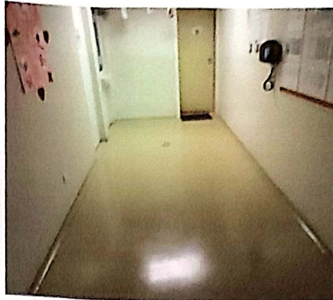
Imagem 21 – corredor interno (piso térreo)
