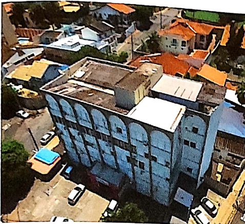
Imagem 52 – foto aérea, com drone, fachada
