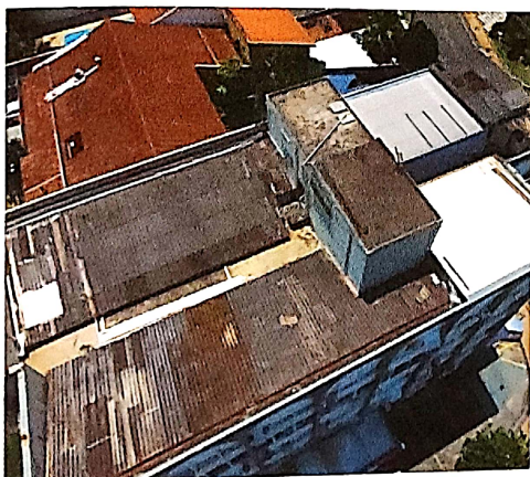
Imagem 54 – foto aérea, com drone, telhado
