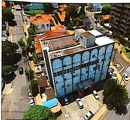
Imagem 53 – foto aérea, com drone, fachada
