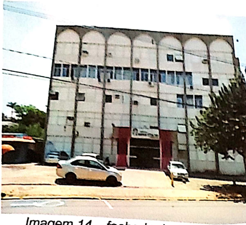
Imagem 14 – fachada do hospital
