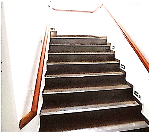
Imagem 24 – escada de acesso aos pisos superiores
