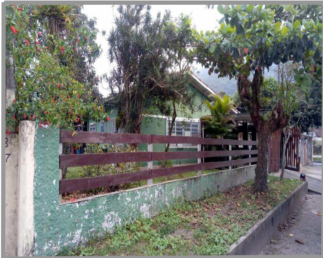
Vista da fachada do avaliando à partir da Rua Azurita, sentido praia continente.
