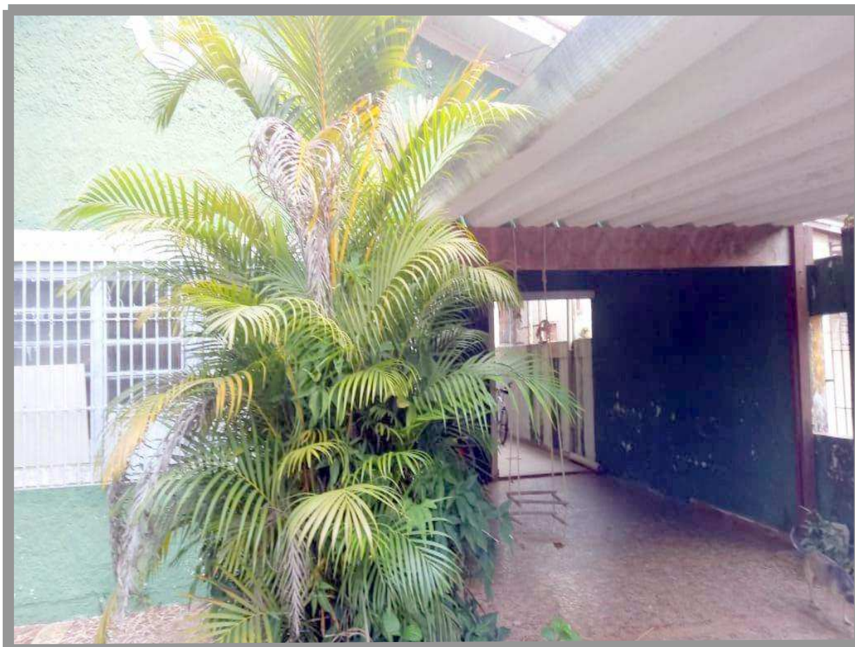
Vista do abrigo para veículos, detalhe da parede necessitando de pequenos reparos.
