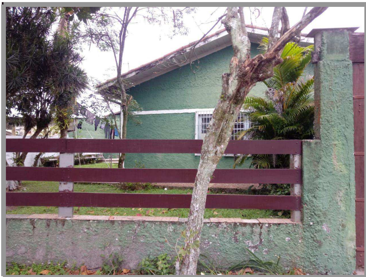
Vista complementar da fachada, detalhe do fechamento frontal com tiras de madeira.
