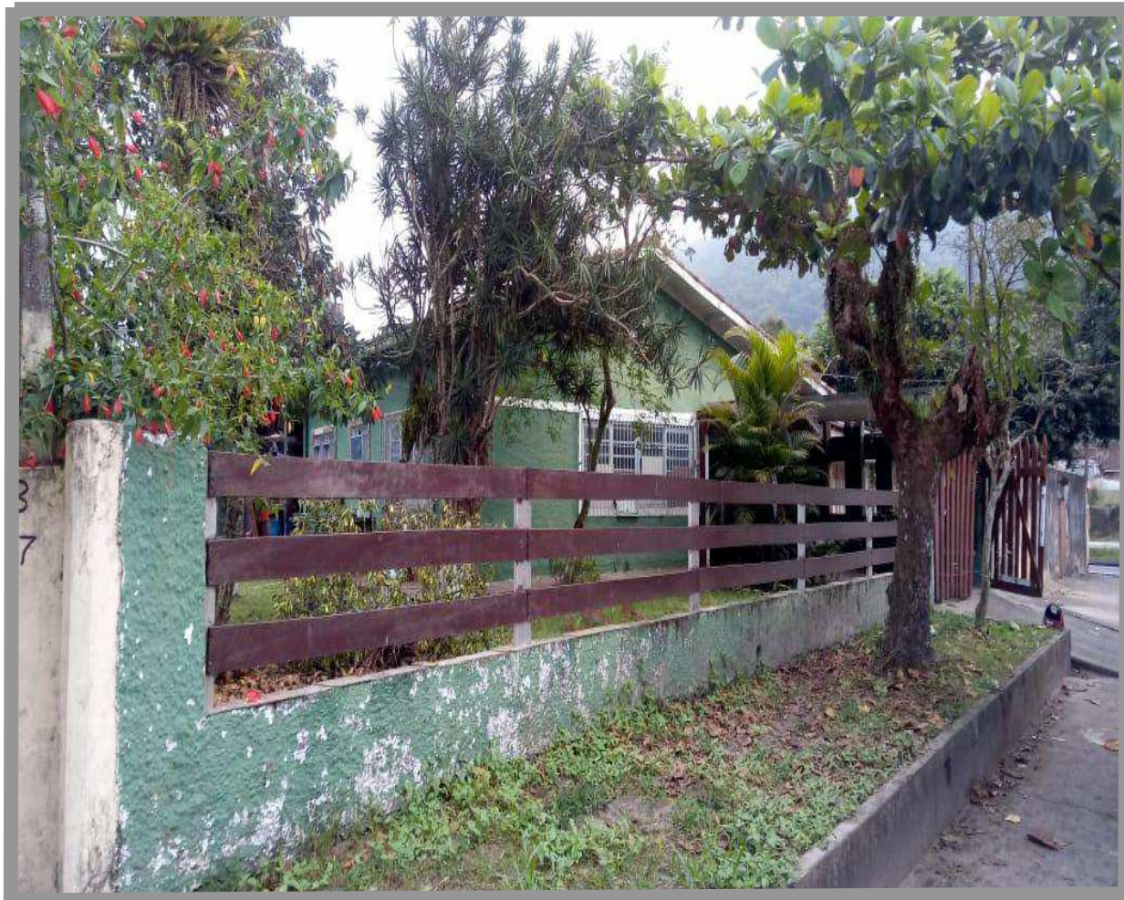
Vista da fachada do avaliando à partir da Rua Azurita, sentido praia continente.
