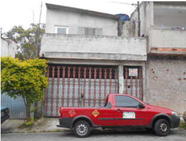
Foto 1 – Frente do imóvel
