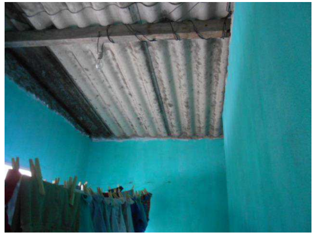
Foto 10 – Área de serviço
