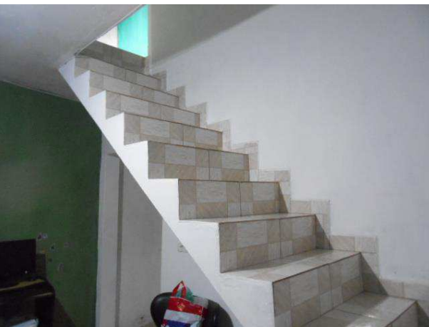
Foto 11 – Escada acesso ao superior
