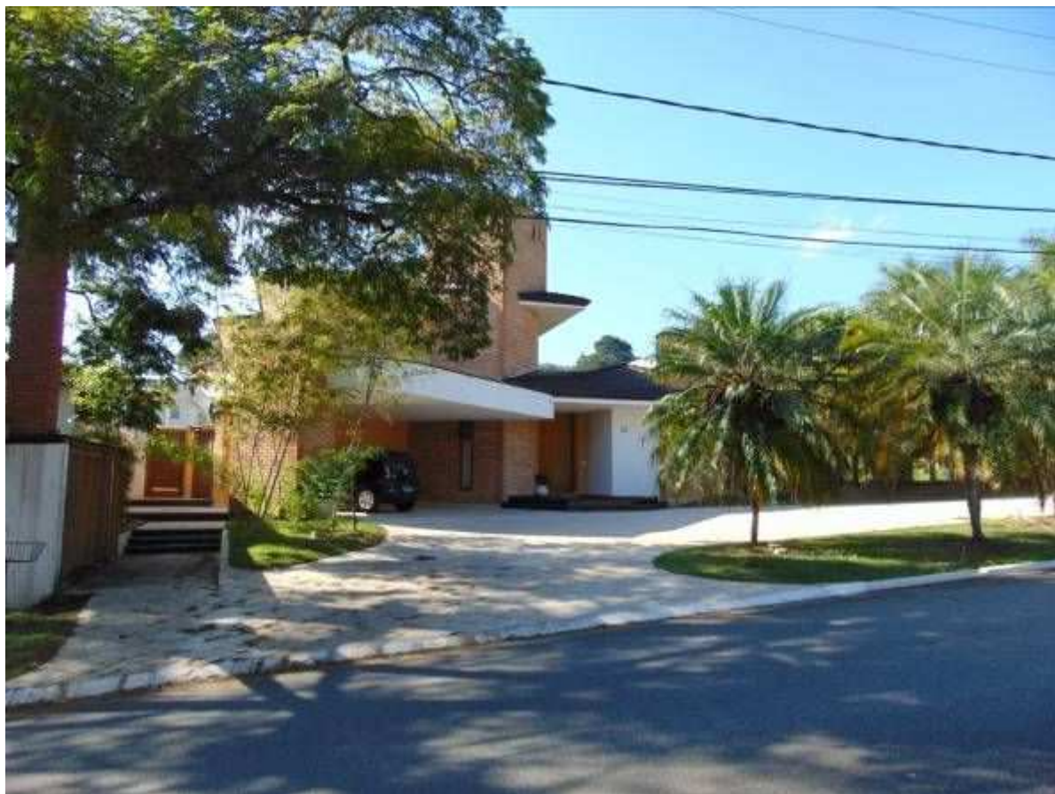
MAIS UMA VISTA DA FACHADA.
