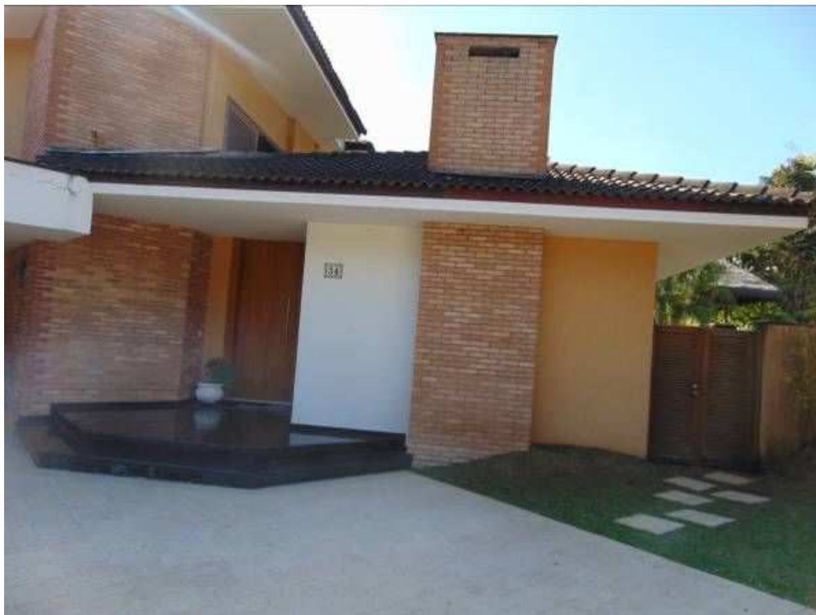
VISTA PARCIAL DA EDIFICAÇÃO.
