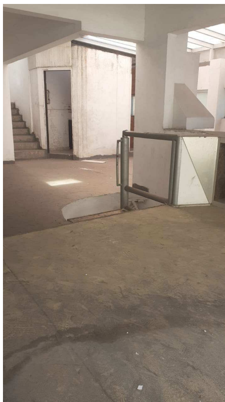
Foto 42 - Vista da sala do segundo pavimento do imóvel periciando.
