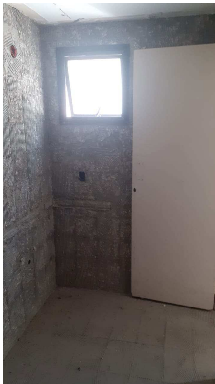
Foto 38 - Vista do banheiro da segunda suíte do imóvel periciando.
