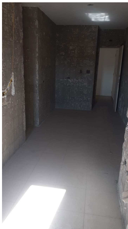
Foto 22 - Vista da cozinha do imóvel periciando.
