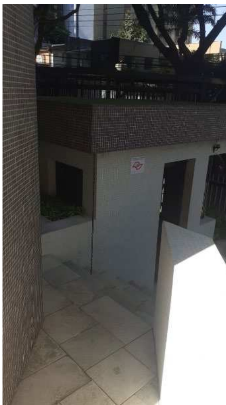
Foto 06 - Vista geral da portaria na área comum do Condomínio.
