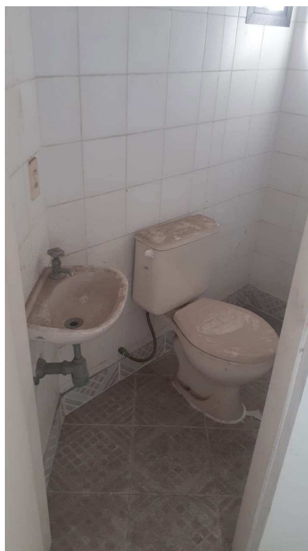
Foto 24 - Vista do banheiro de empregados do imóvel periciando.
