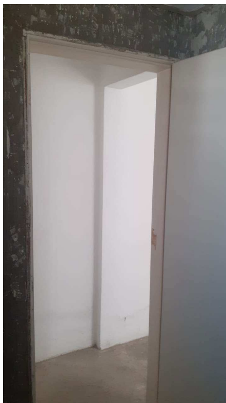
Foto 32 - Vista do banheiro da primeira suíte do imóvel periciando.
