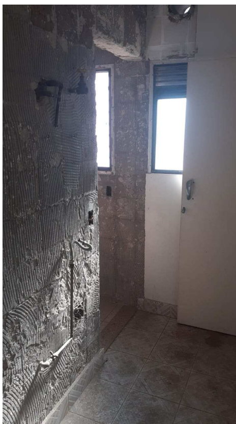
Foto 26 - Vista da área de serviços do imóvel periciando.
