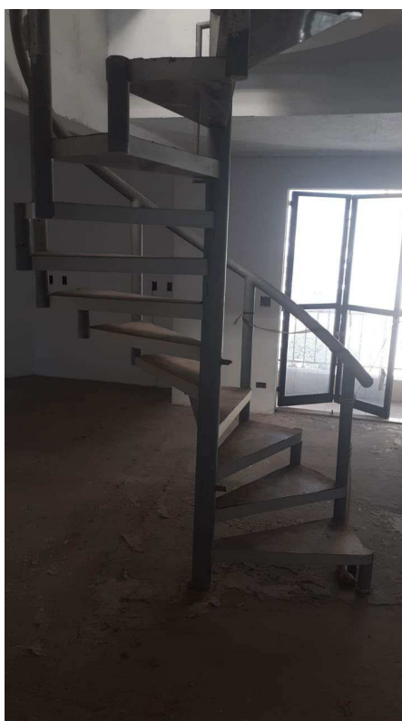
Foto 40 - Vista da escada de acesso ao segundo pavimento do imóvel periciando.
