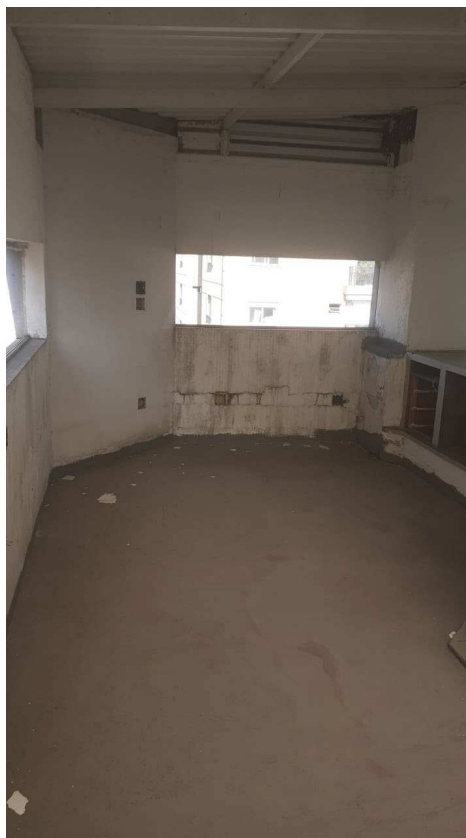
Foto 43 - Vista da área de churrasqueira do 2º pavimento do imóvel periciando.
