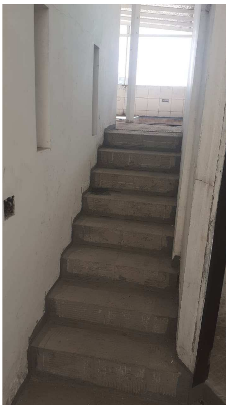
Foto 48 - Vista da escada de acesso a piscina do imóvel periciando.
