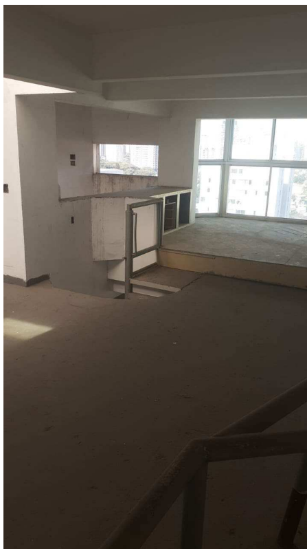
Foto 41 - Vista da sala do segundo pavimento do imóvel periciando.
