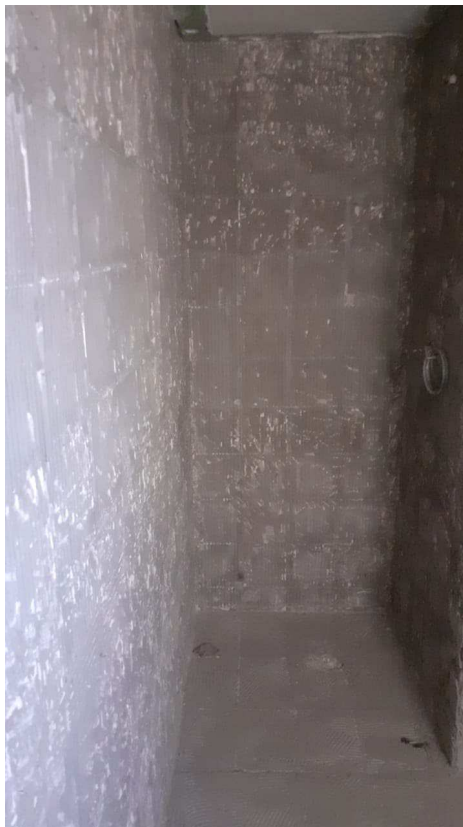
Foto 37 - Vista do banheiro da segunda suíte do imóvel periciando.
