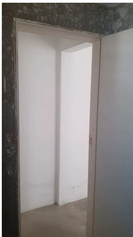
Foto 34 - Vista do banheiro da primeira suíte do imóvel periciando.
