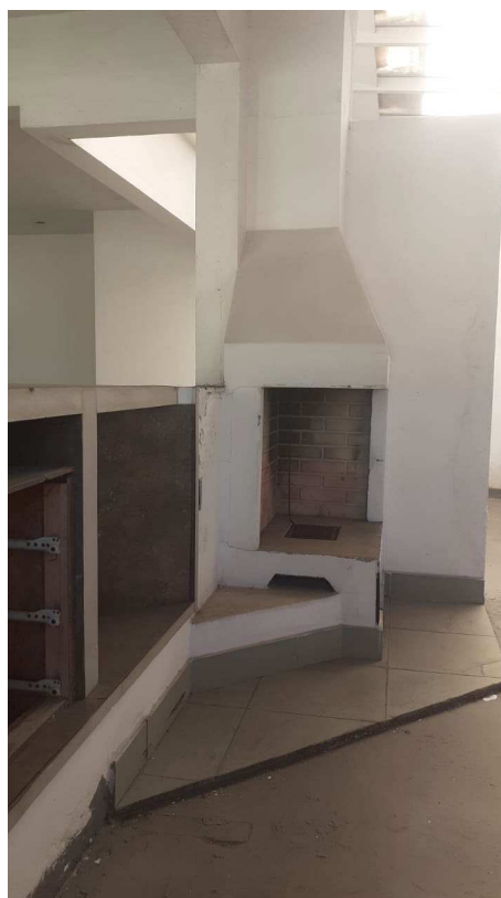
Foto 44 - Vista da área de churrasqueira do 2º pavimento do imóvel periciando.
