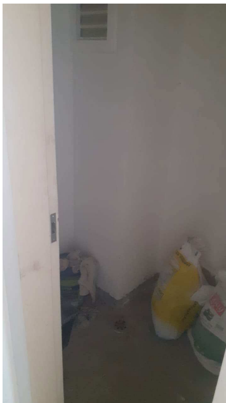
Foto 39 - Vista do lavabo do primeiro pavimento do imóvel periciando.
