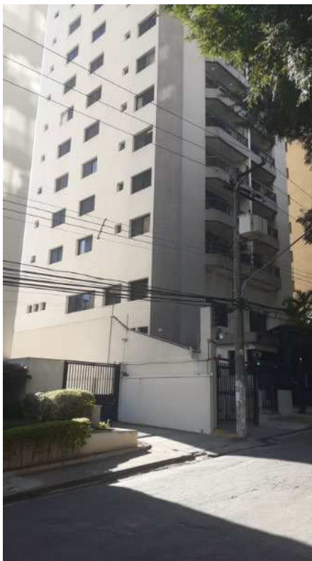
Foto 01 - Vista geral da fachada do Condomínio.
