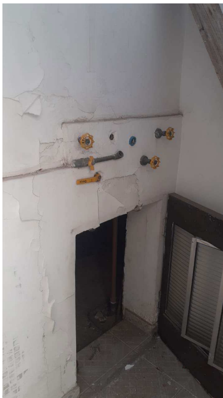
Foto 47 - Vista da casa de máquinas do 2º pavimento do imóvel periciando.
