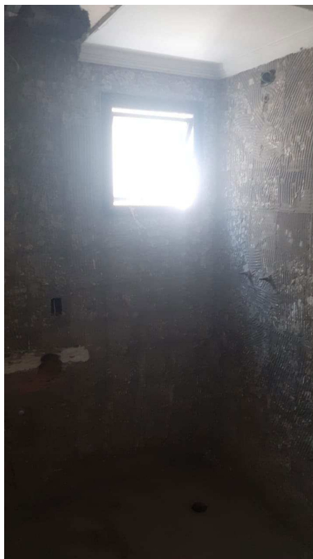
Foto 31 - Vista do banheiro da primeira suíte do imóvel periciando.
