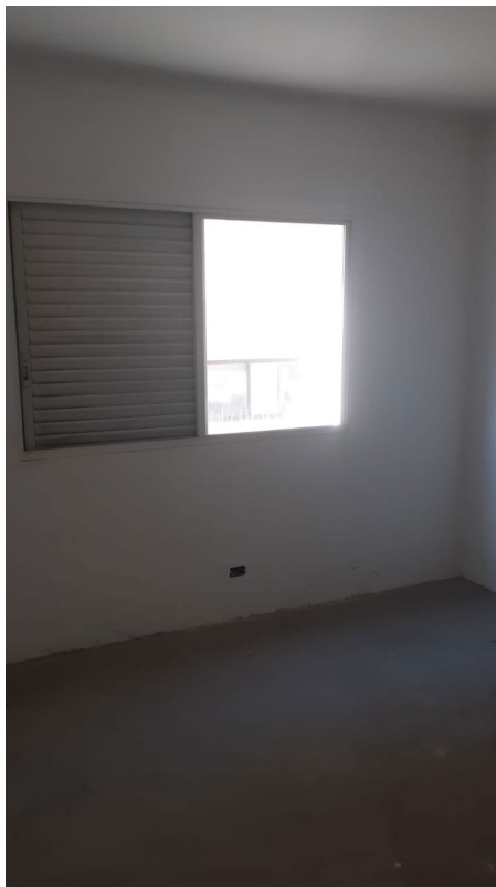
Foto 35 - Vista da segunda suíte do imóvel periciando.
