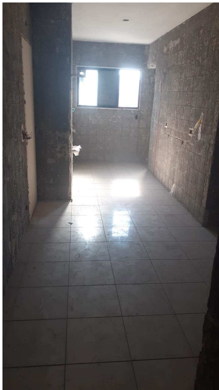
Foto 21 - Vista da cozinha do imóvel periciando.
