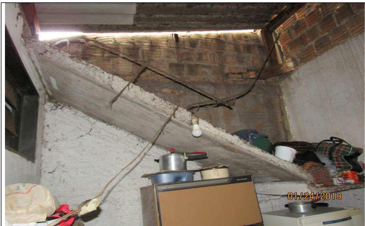
FOTO 10 – Vista de vão preparado para execução de escada e aumento da área construída da residência.
