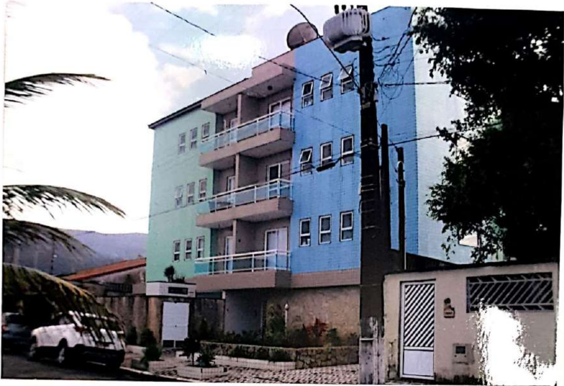
Foto nº 01 – fachada do EDIFÍCIO SANGARUGA, do apartamento nº 102 avaliando, frente para Rua Amapola
