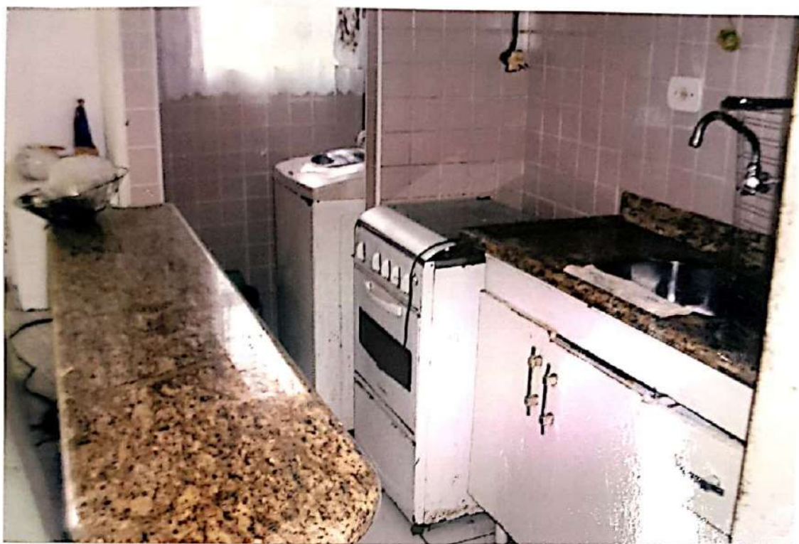
foto nº 15 - cozinha com piso e paredes de cerâmica, pia com cuba inox e tampo de granito, armários de madeira e bancada de granito.
