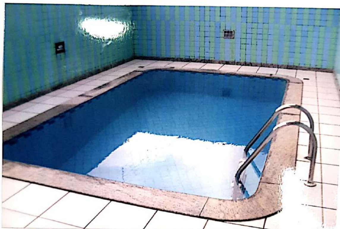
Foto nº 7 – piscina do Condomínio
