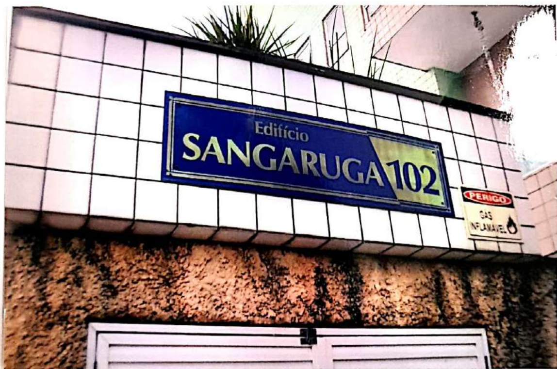
Foto nº 4 - Detalhe da fachada do Condomínio
