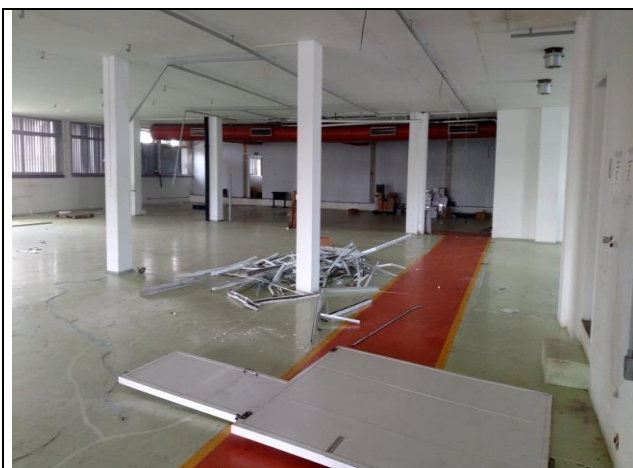
Piso superior com portas e eletrocalhas arrancadas
