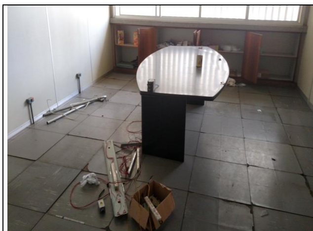
Escritório – Sala de Reunião danificada
