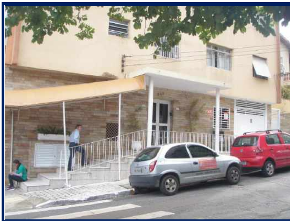
Vista da frente do Edifício Ana Bolena, onde se localiza o imóvel 01 avaliando.
