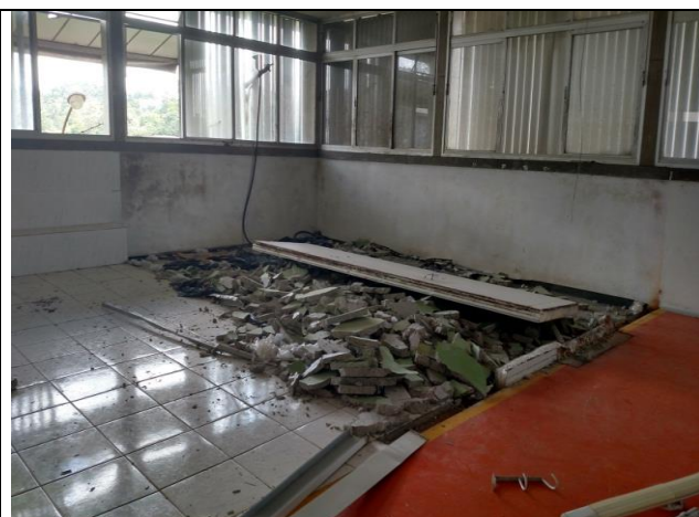
Piso superior danificado e ausência de vidros nas janelas
