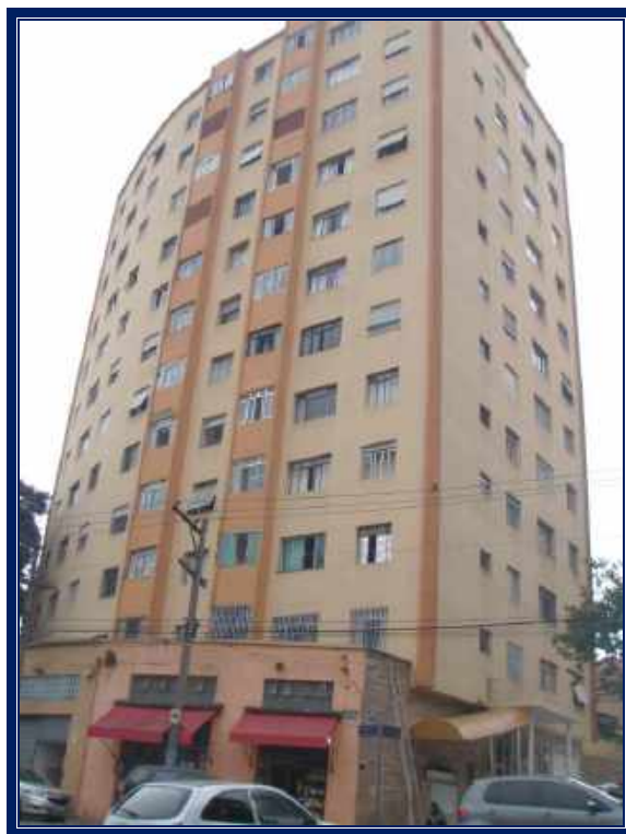
Vista do Edifício Ana Bolena, onde se localiza o imóvel 01.
