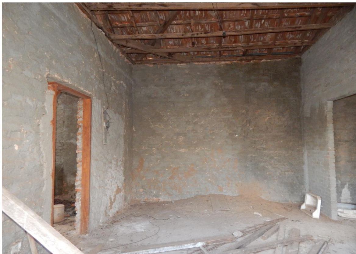
FOTO 07 – Vista interna sala
