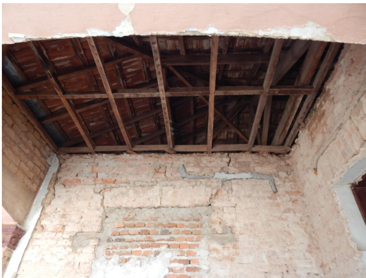
FOTO 04 – Vista parcial área da frente telhado
