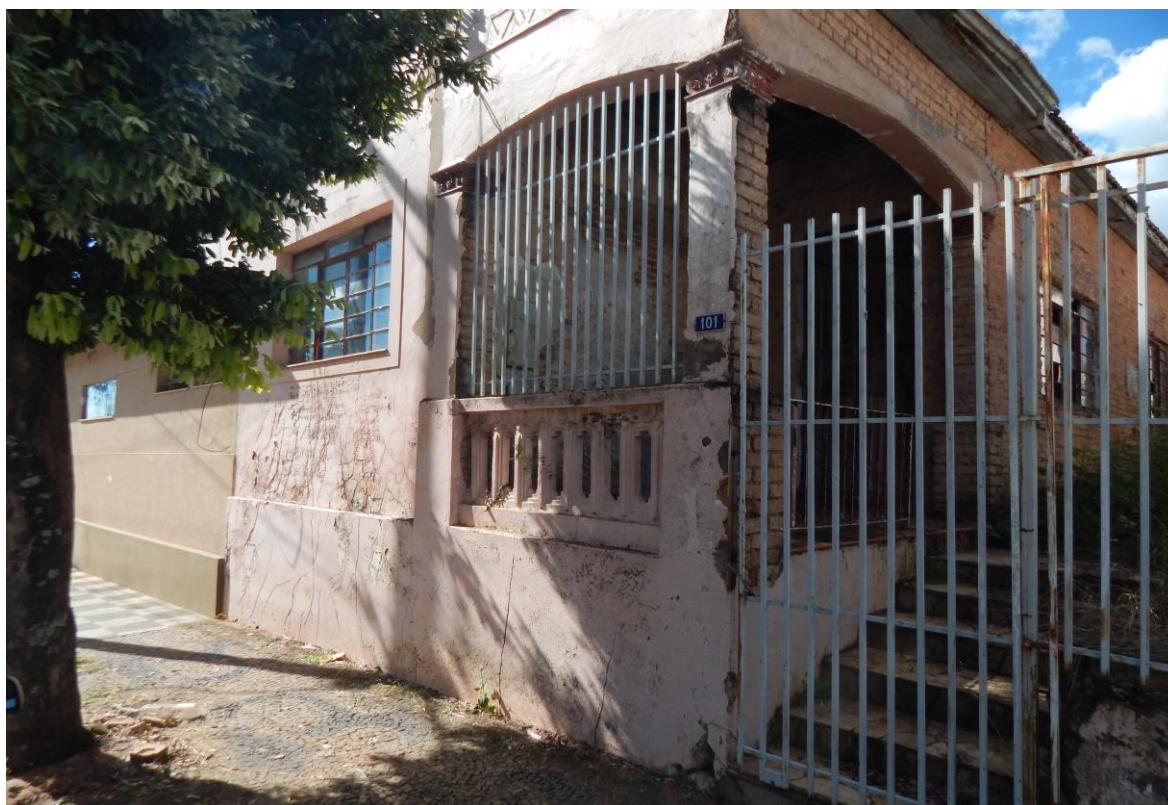
FOTO 01 – Vista frente Rua Júlio Prestes
