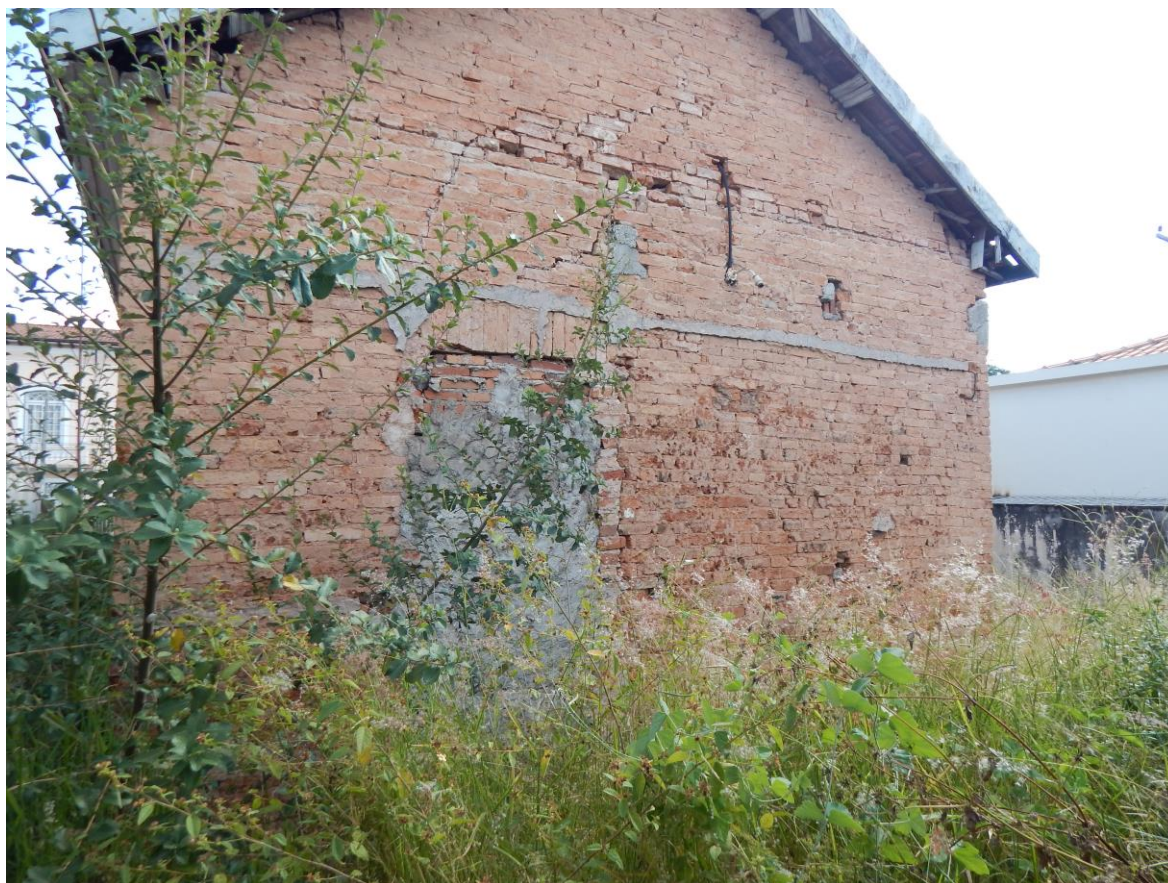
FOTO 13 – Vista fundos acesso fechado com alvenaria
