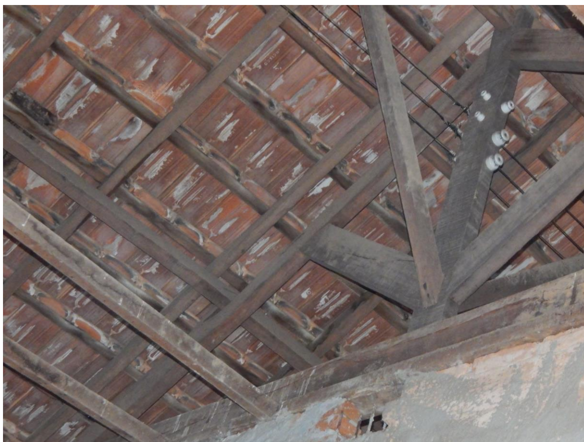
FOTO 08 – Vista interna telhado
