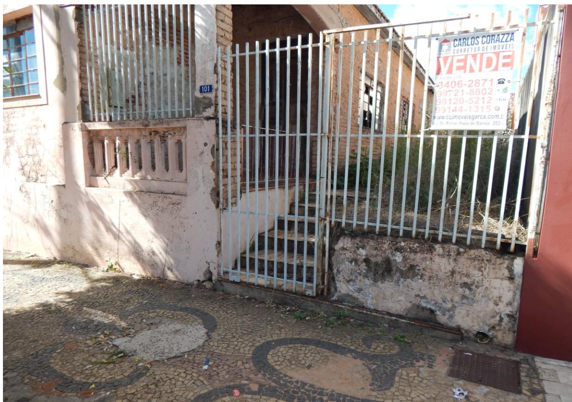
FOTO 02 – Vista frente Rua Júlio Prestes
