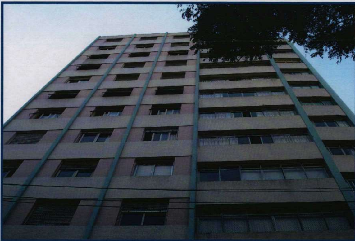
FOTO nº 04 Vista da fachada frontal do Condomínio Edifício Jangada.
