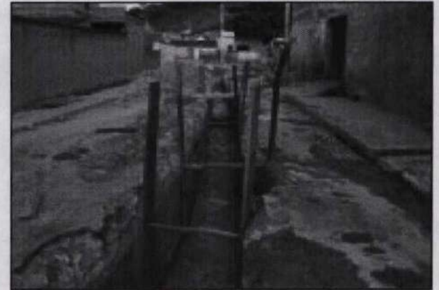
Obra na Rua José Augusto Farias, no Bairro Santa Clara
