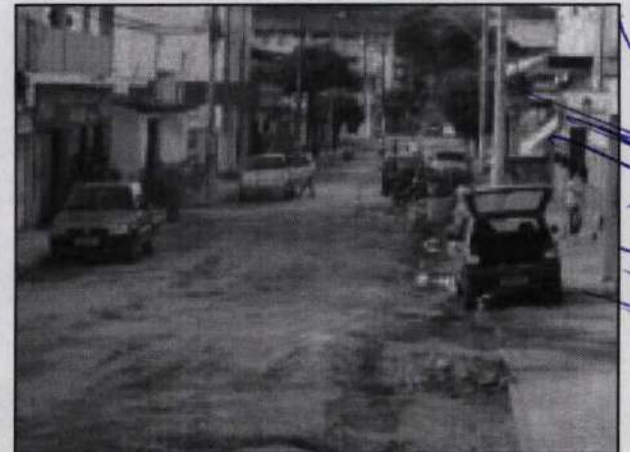
Melhorias no Bairro Santa Clara deverão facilitar o escoamento
