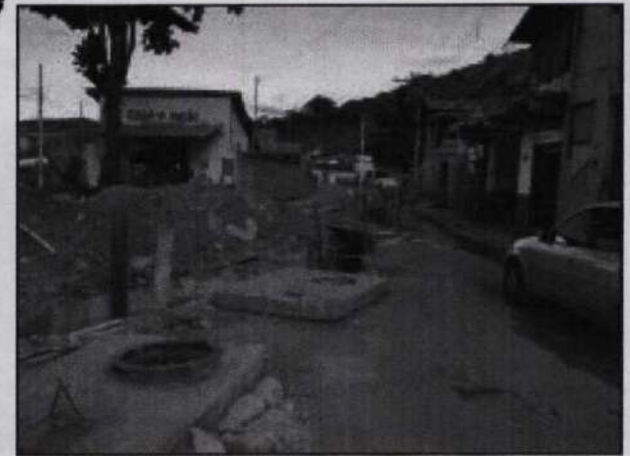
Obras de ampliação da rede pluvial estão avançadas
