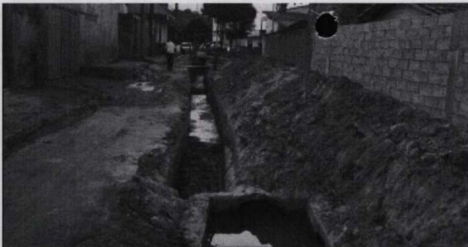
A Prefeitura deu continuidade às obras que visam melhorar o escoamento das águas nos bairros Santa Clara e Castro Pires
