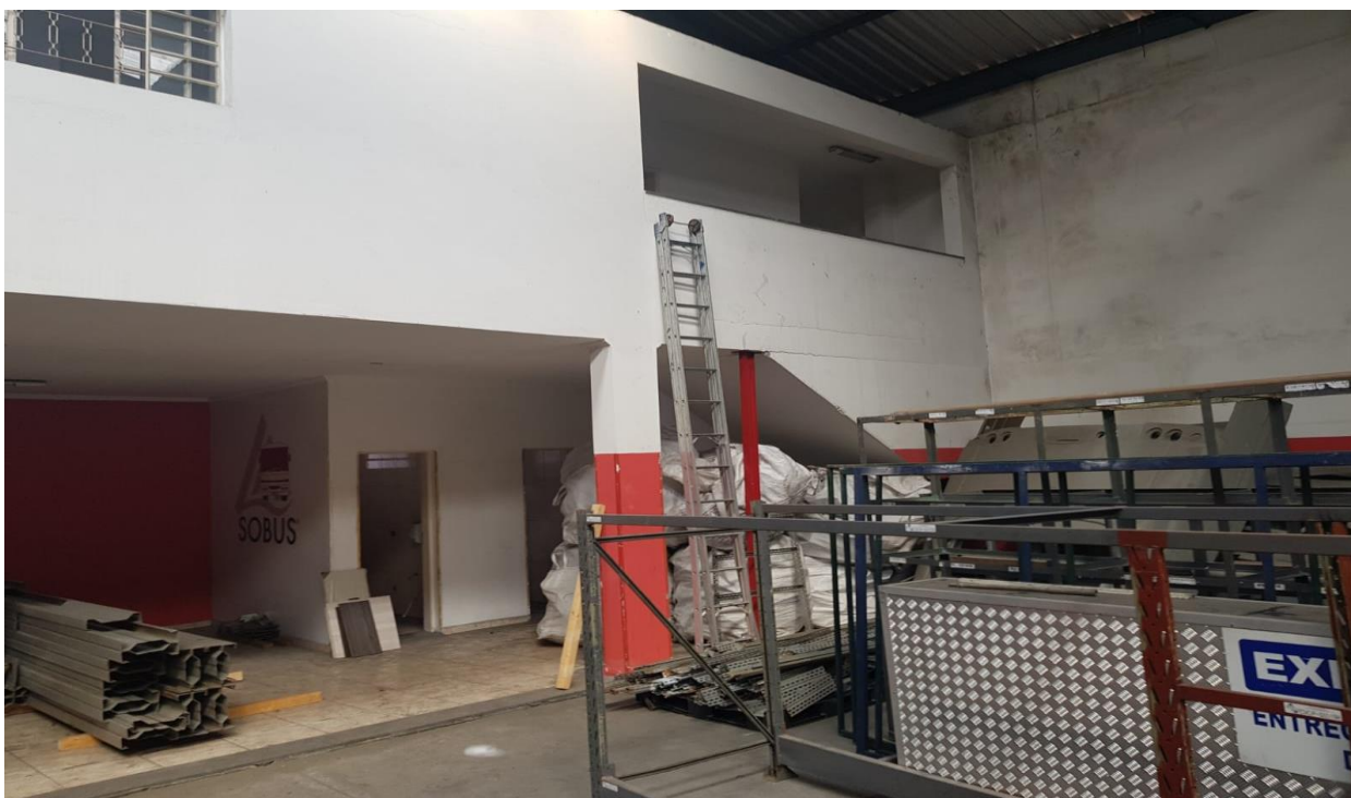
Foto 5 – Pavimento térreo – vista do setor de administração
