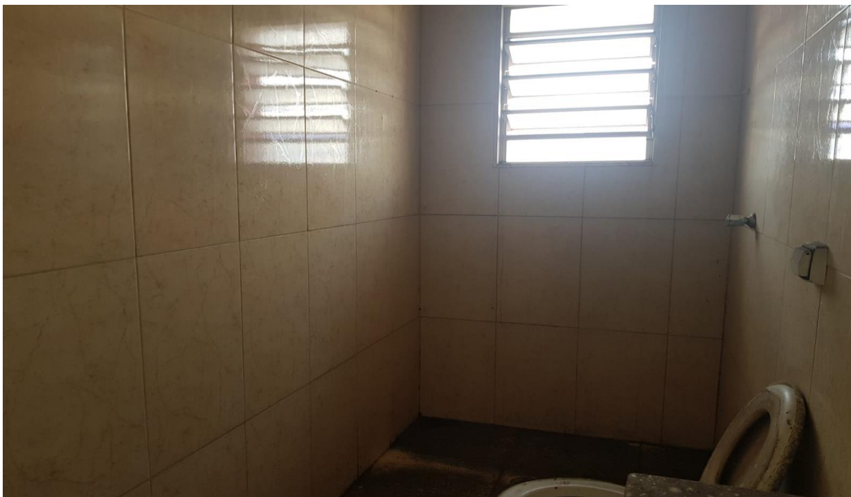
Foto 16 – Sanitário 2 – setor de administração
