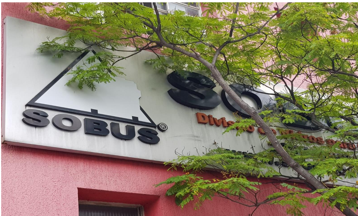
FOTO 2 – Placa de identificação instalada na fachada (05/10/21)
