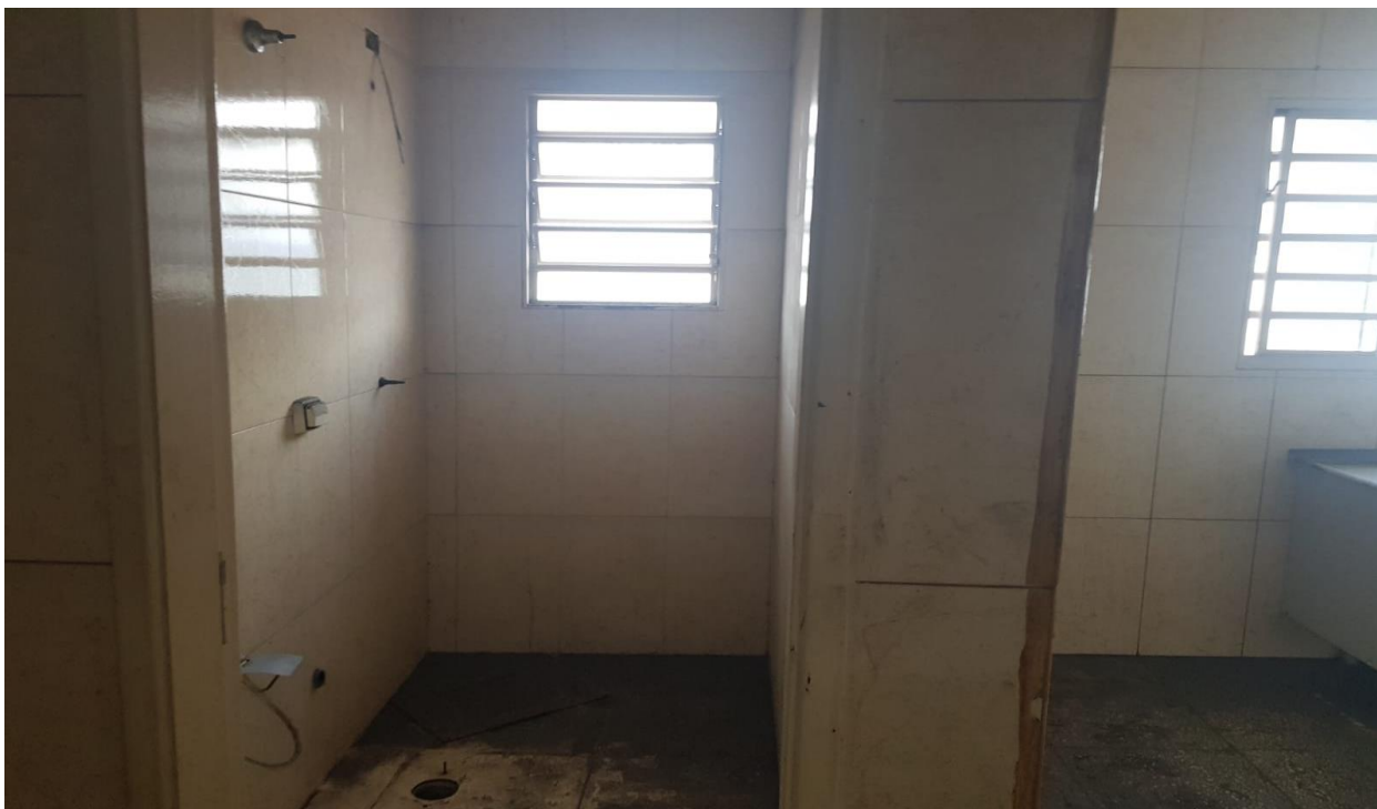
Foto 15 – Sanitário 1 – setor de administração
