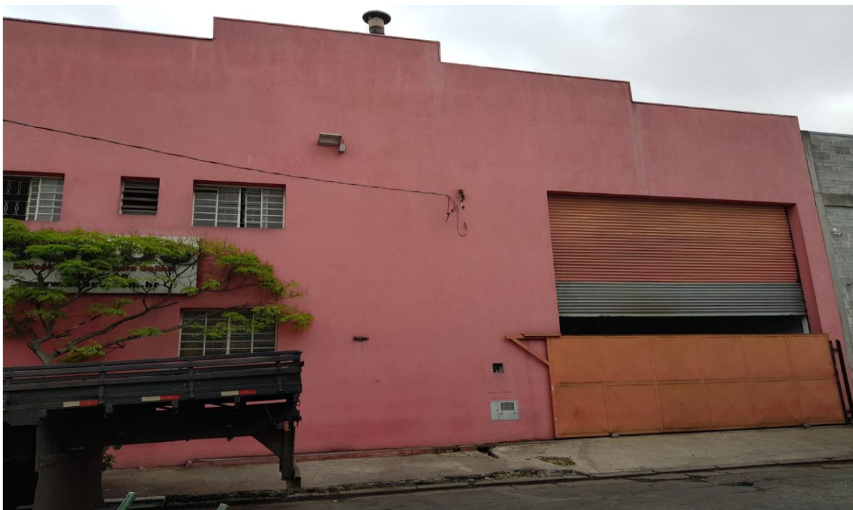
FOTO 4 – Porta de enrolar em aço aberta - portão externo, de correr, trancado (07/10/21)
