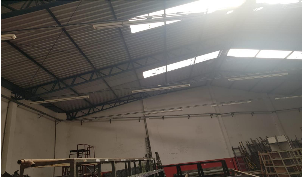
Foto 12 – Interior do galpão – cobertura e estrutura
