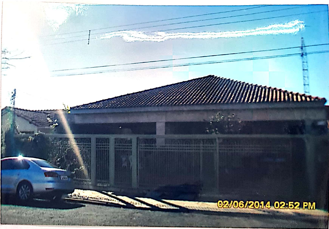
Foto 01 – Vista parcial frente
