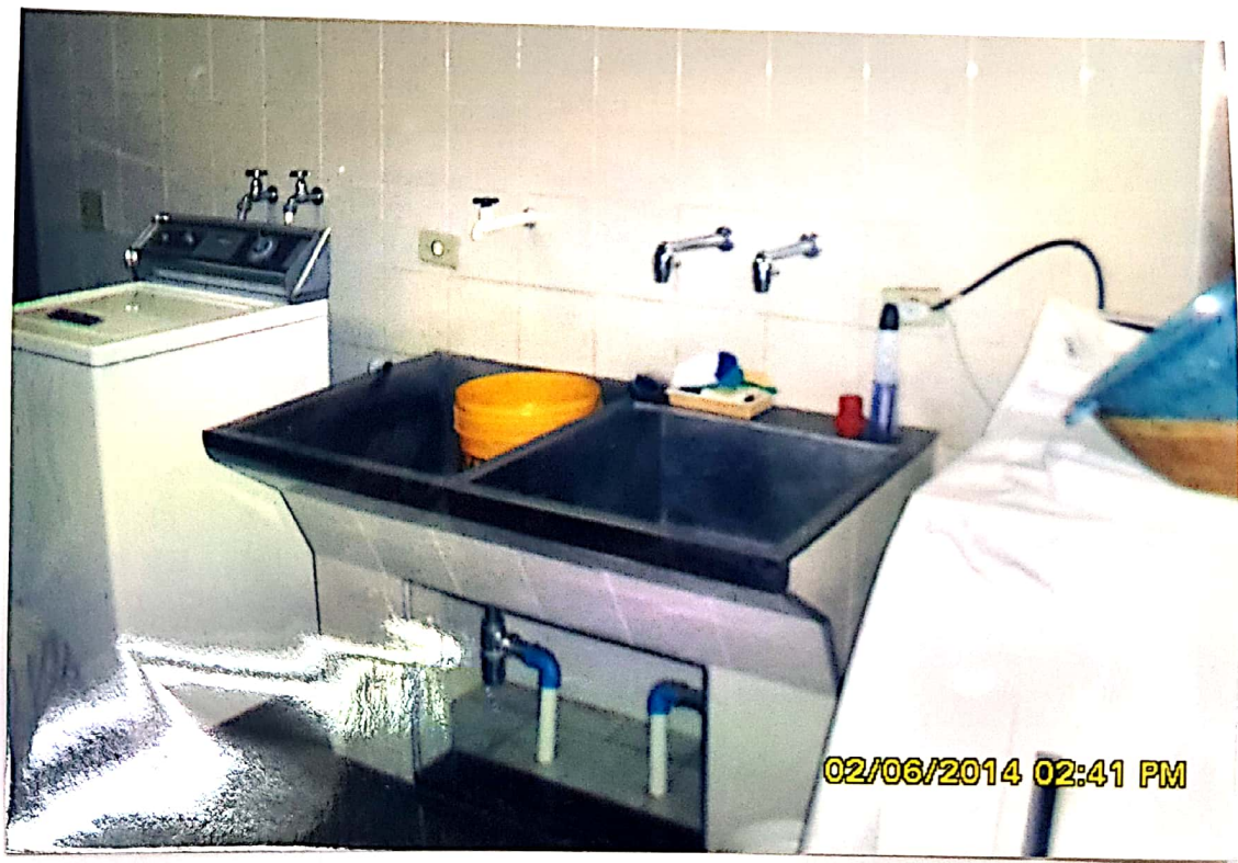
Foto 52 Vista parcial área de serviço – detalhe tanque
