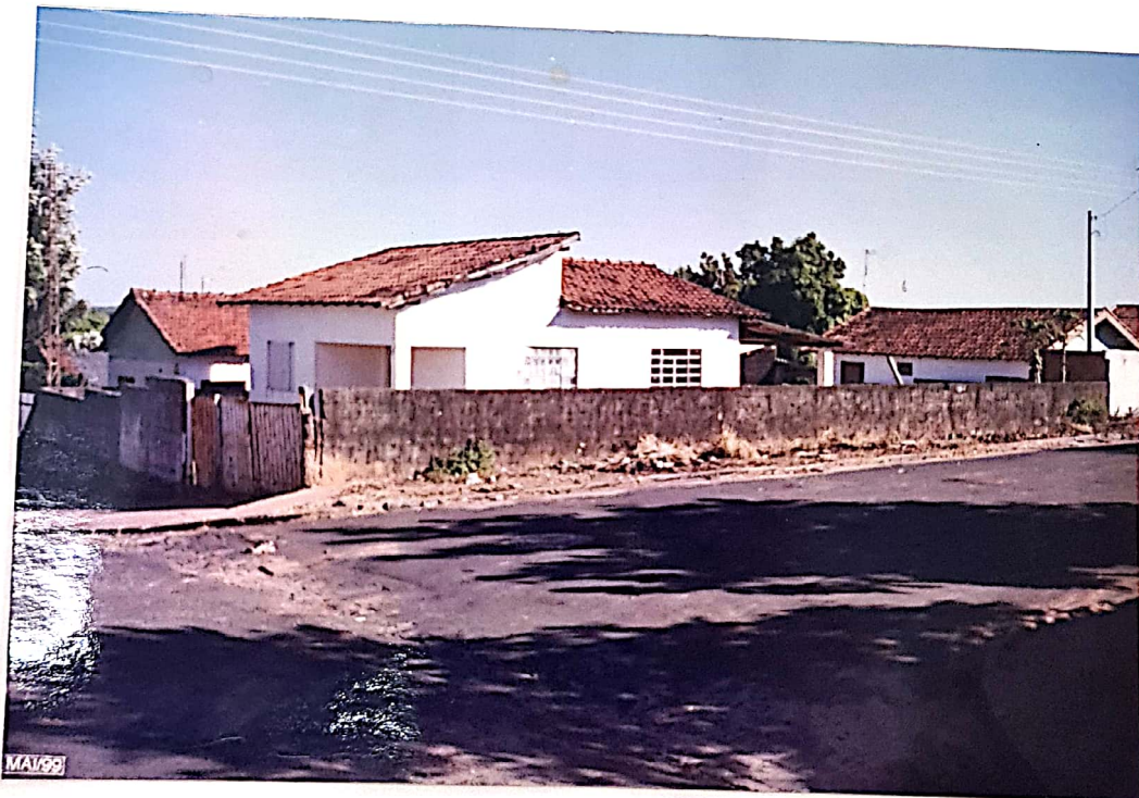
Foto nº 02 - Ilustra frente e lateral esquerda do imóvel residencial.
