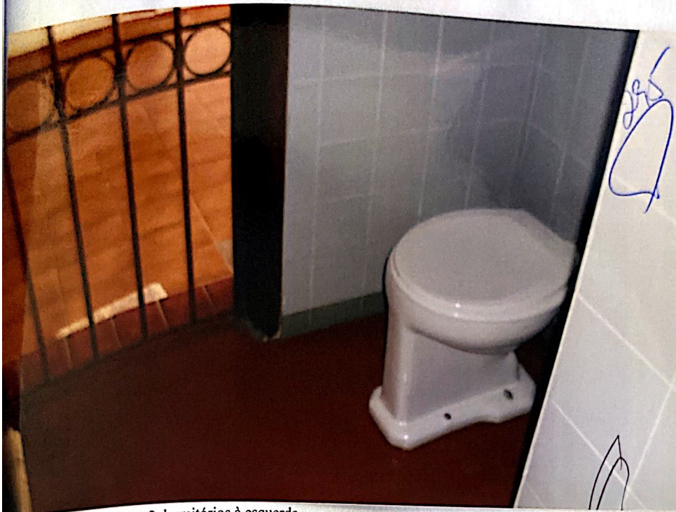
foto nº 14 -banheiro social dos 2 dormitórios à esquerda
