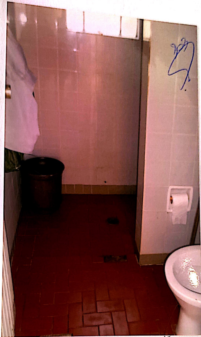
Foto nº 29 - banheiro com piso de cerâmica vermelha e paredes de azulejo
