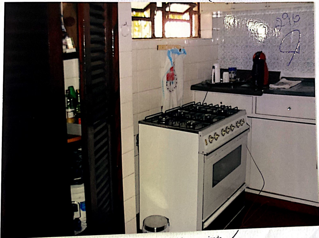
foto nº 15- cozinha com piso de lajota e paredes revestidas de cerâmica, e armário de madeira envernizada.
