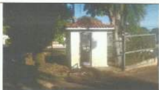
Foto 9. Vista da guarita de segurança na entrada do imóvel, citada no item "e".
