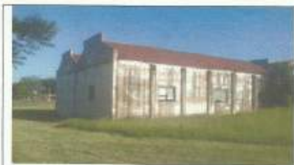
Foto 8. Foto do barracão em alvenaria citado no item "d".
