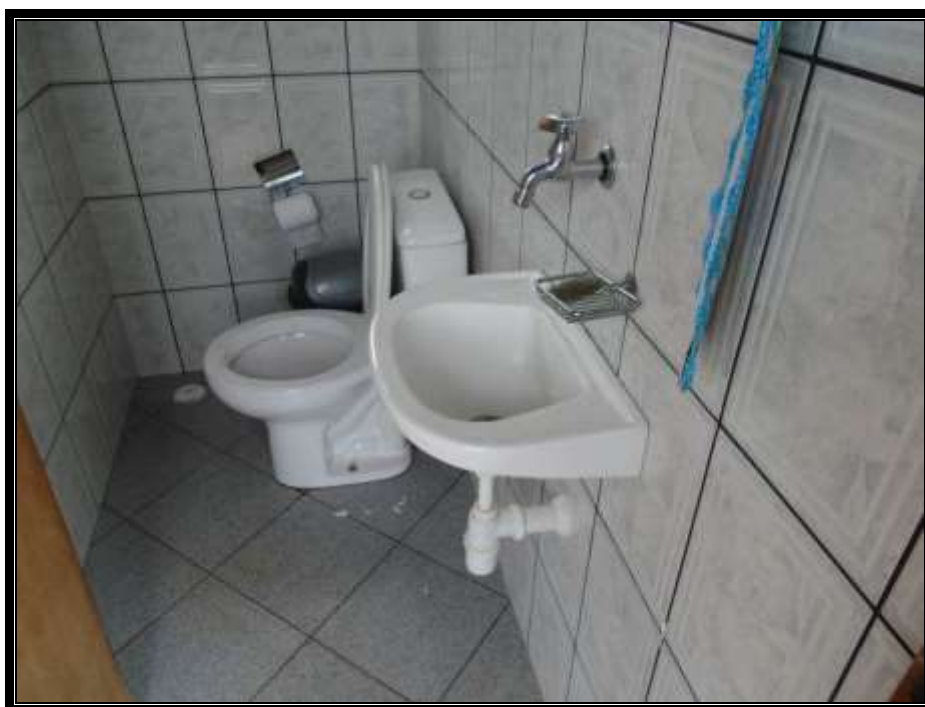
Vista do banheiro externo II.
