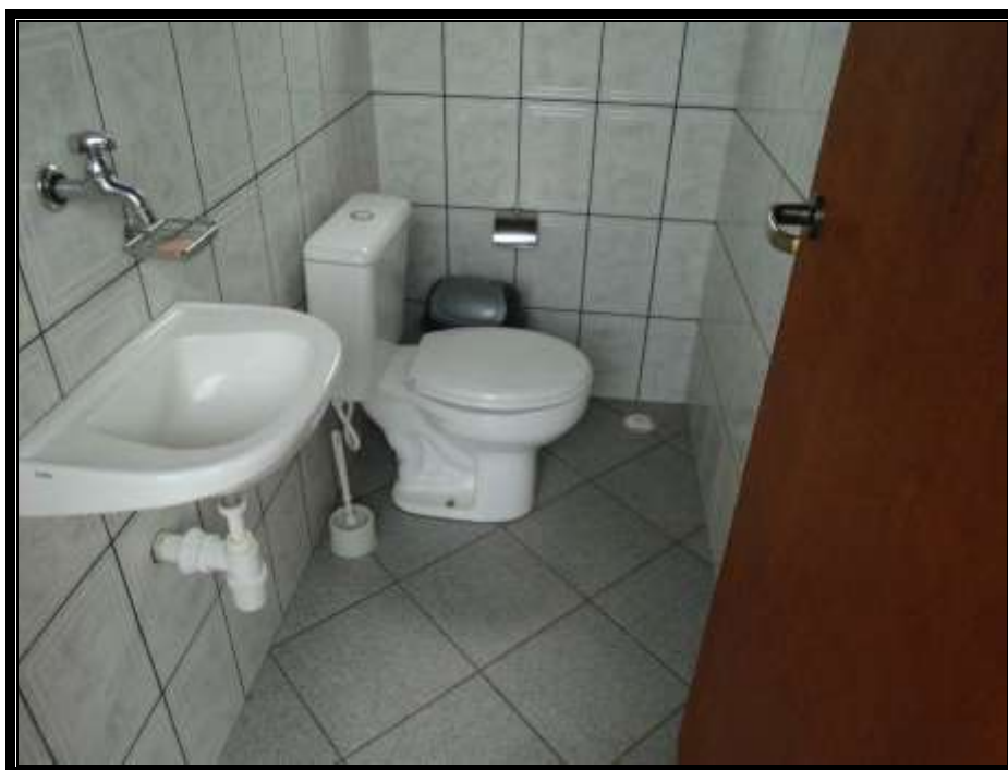
Vista do banheiro externo I.
