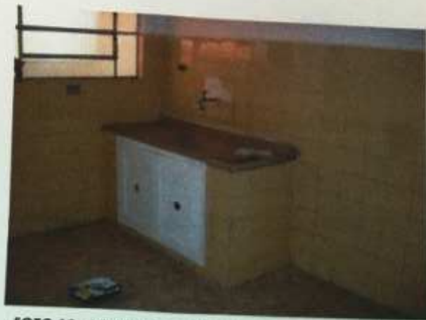
FOTO 10: - Vista interna do imóvel avaliando. Cozinha.
