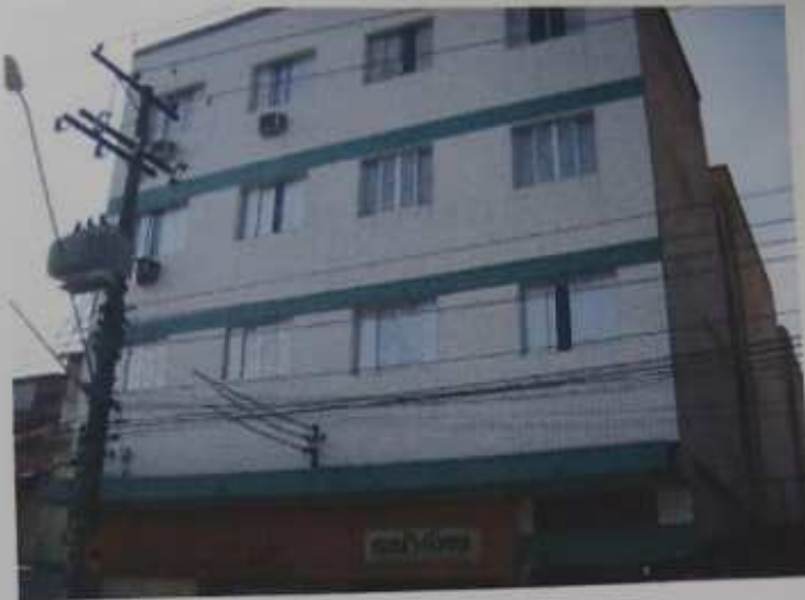
FOTO 02: Fachada do Edifício Rally diante da Rua Frei Gaspar.
