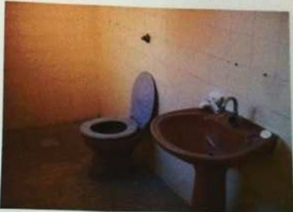
FOTO 08: - Vista interna do imóvel avaliando. Banheiro Social.
