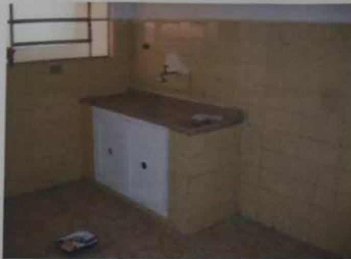
FOTO 10:- Vista interna do imóvel avaliando. Cozinha.
