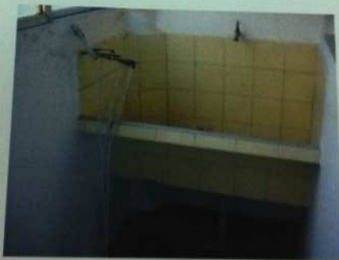
FOTO 11: - Vista interna do imóvel avaliando. Área de serviço. de
