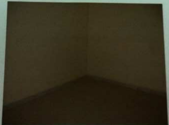
FOTO 09: - Vista interna do imóvel avaliando. Dormitório.
