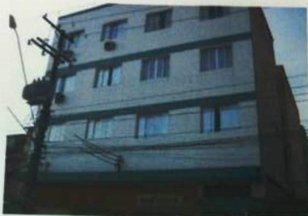
FOTO 02: Fachada do Edifício Rally diante da Rua Frei Gaspar.
