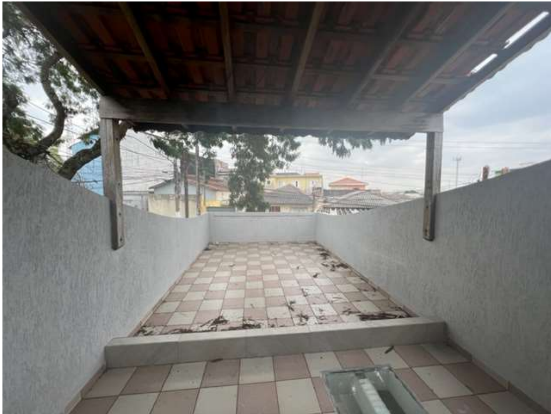
Foto 15: Piso superior – varanda.
