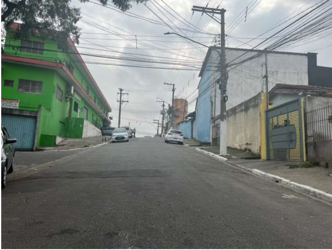
Foto 16: Vista da Rua Graviola.
