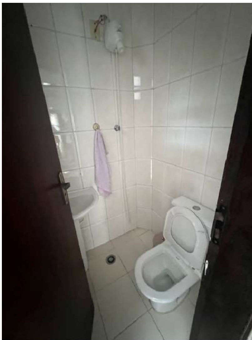
Foto 6: Piso térreo – Banheiro.
