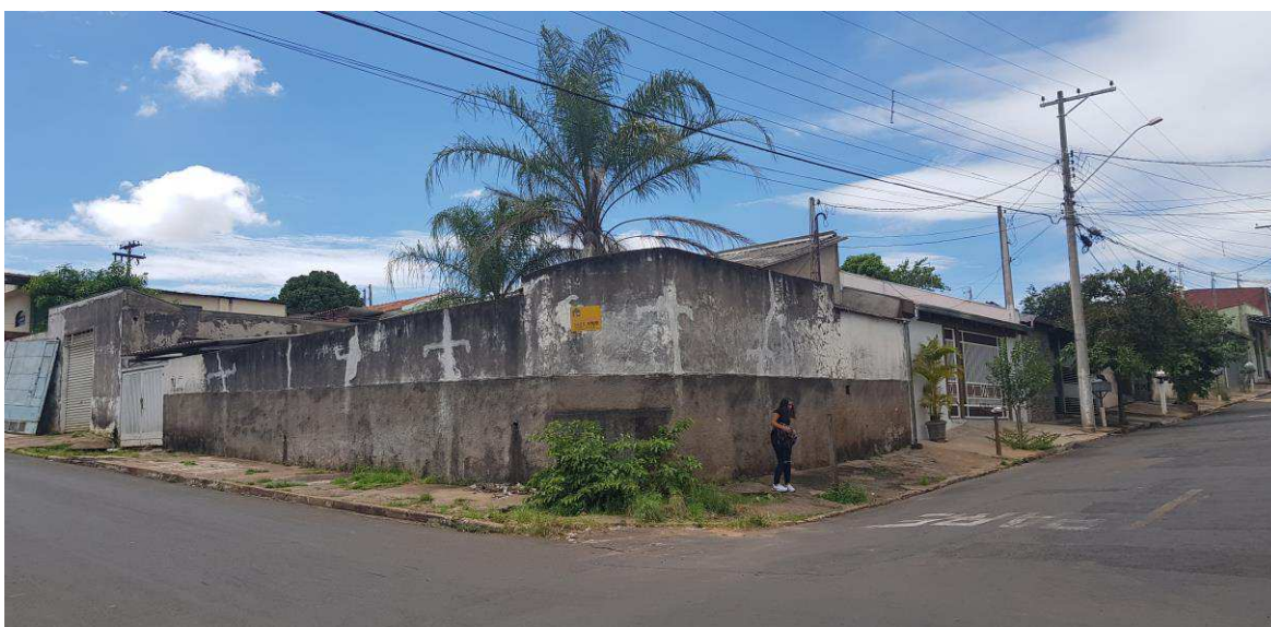
Vista da edificação esquina das Rua Alcides Caliman e Miguel Pastori.
