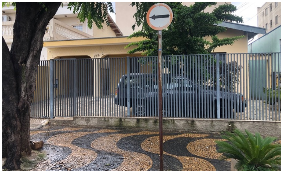
Imagem 03: Fachada do imóvel visto da Rua Dr. Las Casas dos Santos
