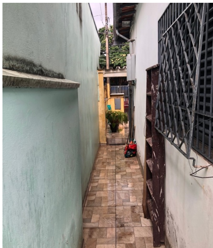
Imagem 26: Corredor de acesso a frente do imóvel
