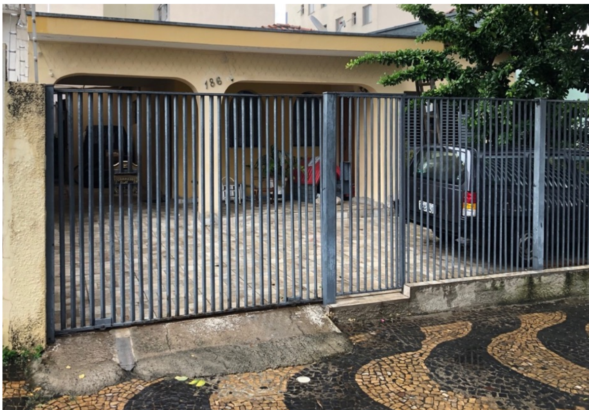
Imagem 02: Fachada do imóvel visto da Rua Dr. Las Casas dos Santos
