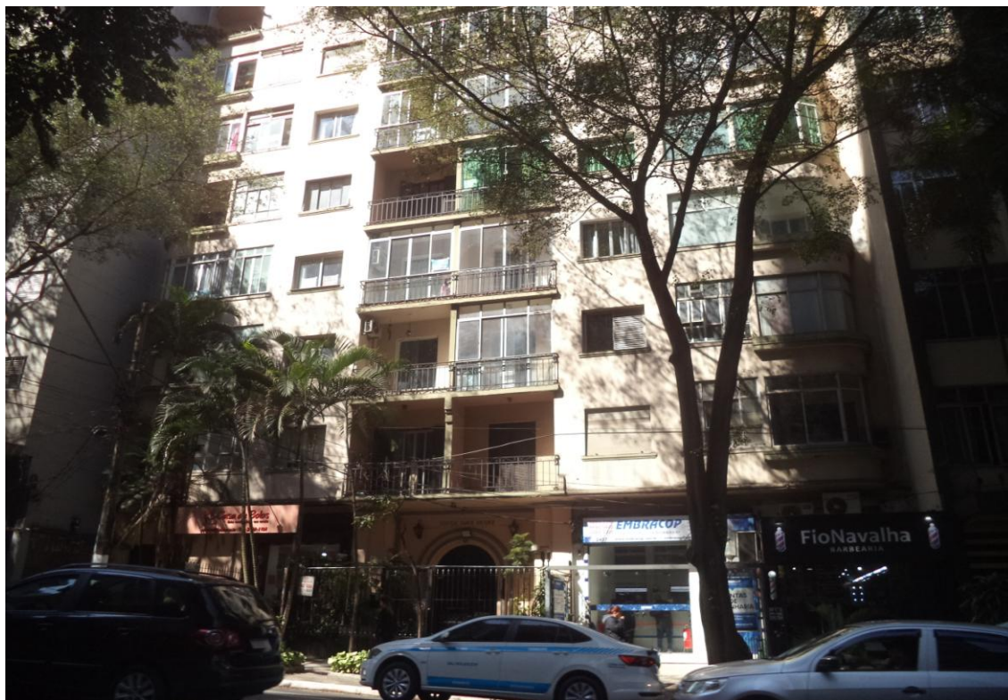
Vista parcial da fachada do edifício
