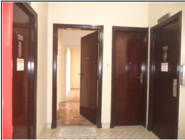
Hall do 4º pavimento – apto nº 41 vistoriado
