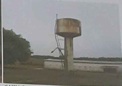
CAIXA D'AGUA N° 2
