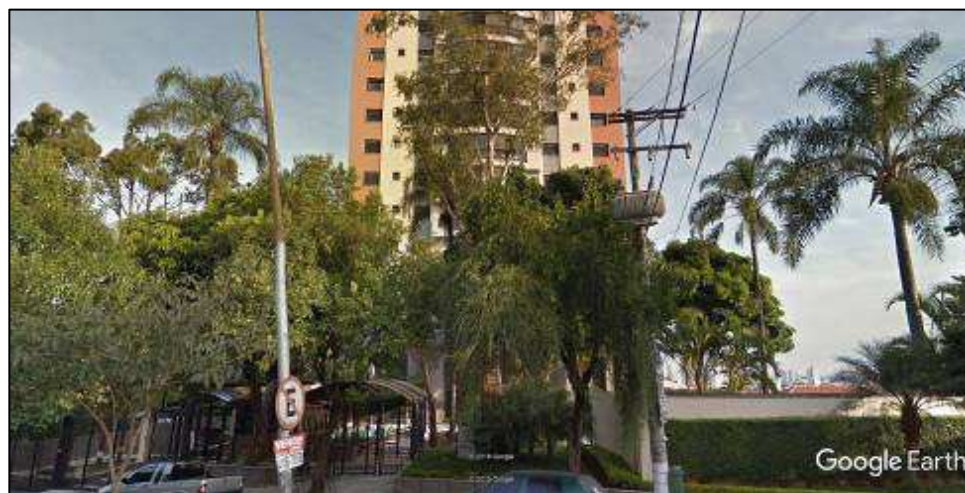
FOTO 03: VISTA DA DO EDIFÍCIO BRASÍLIA EVEREST.
