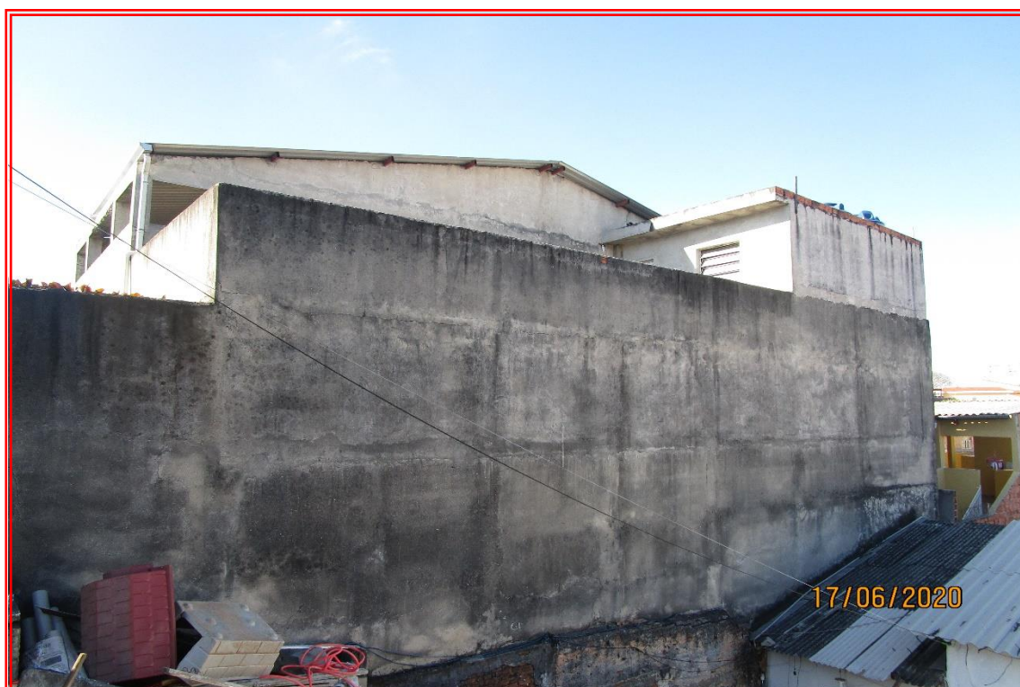
Foto nº 02: Detalhe para a lateral do imóvel avaliando.
