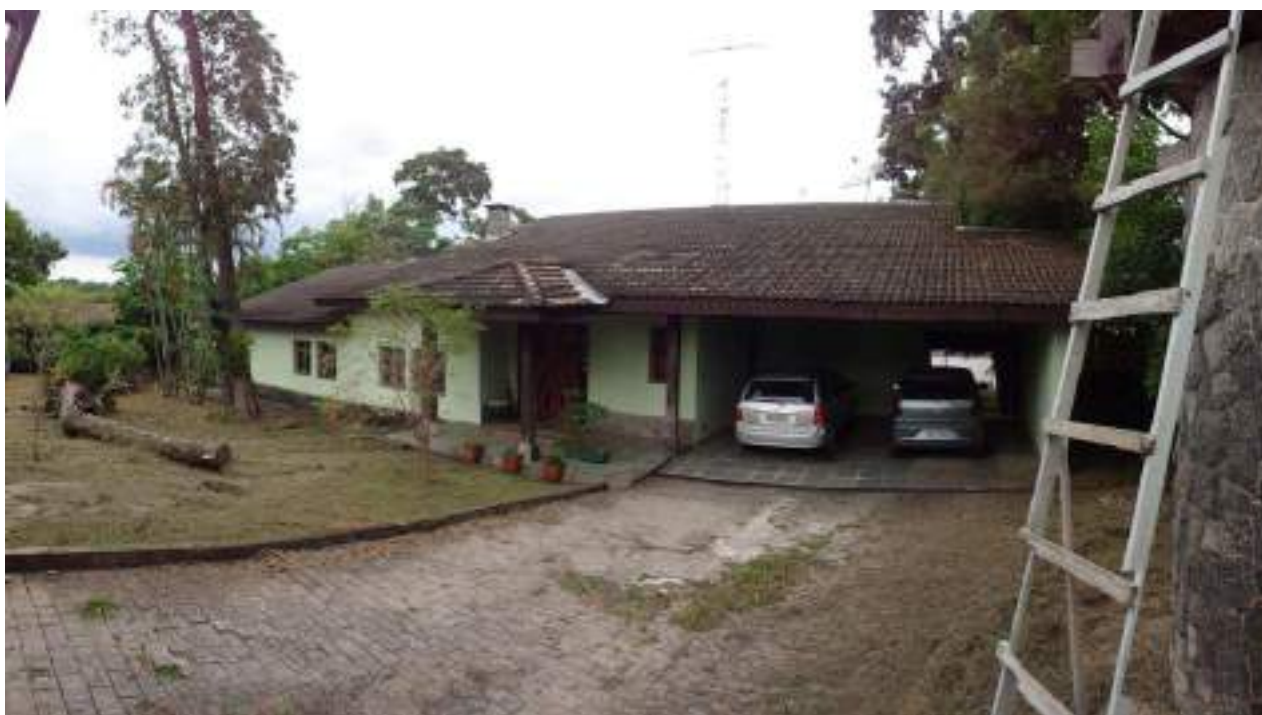
Foto 4. Vista da fachada.
