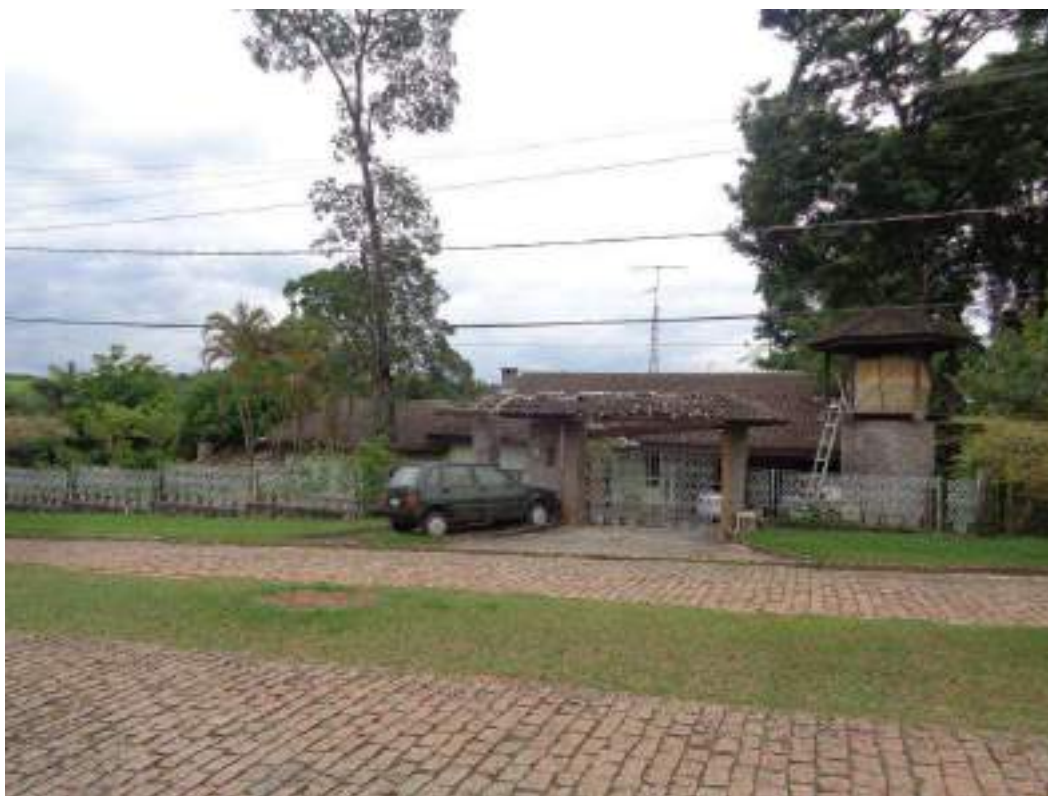
Foto 1. Fachada do imóvel.
