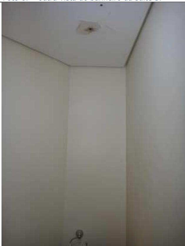
Foto 69 – outra vista do lavabo com sinais de infiltração no forro.
