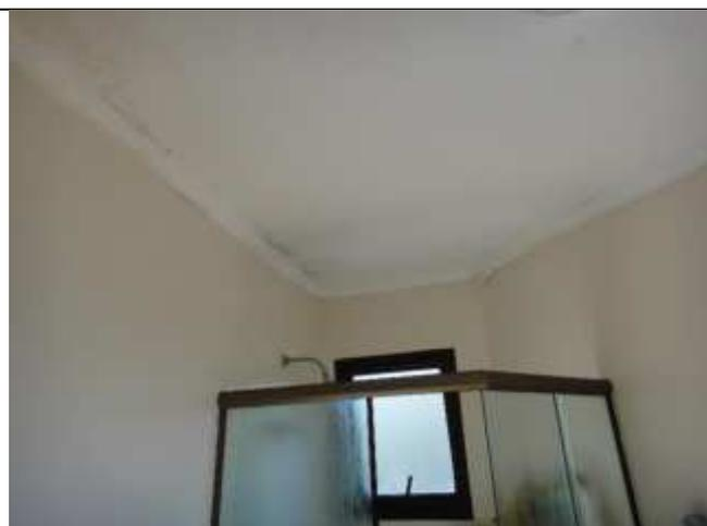
Foto 53 – outra vista do banheiro da suíte máster com sinais de infiltração no forro.
