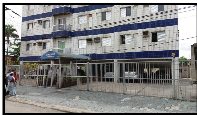
Figura 4 - Entrada do condomínio
