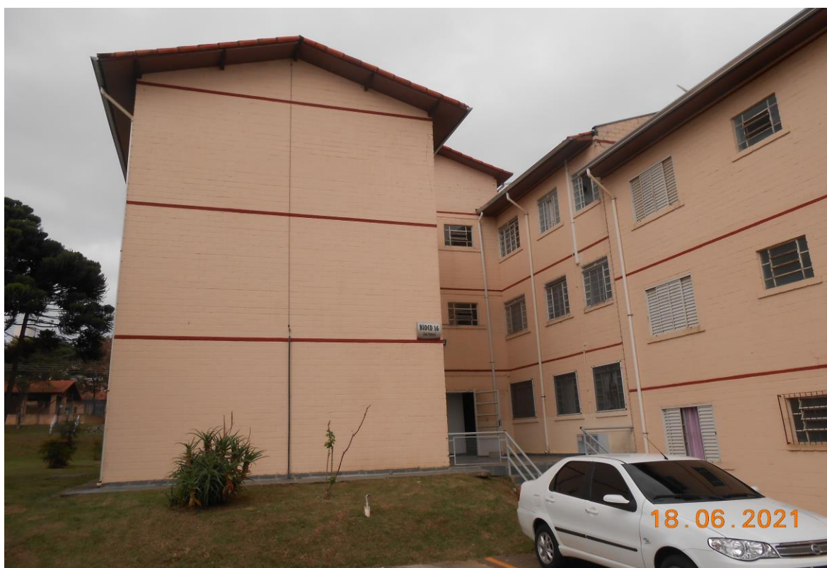
Foto 2: Vista da entrada do bloco 16.
