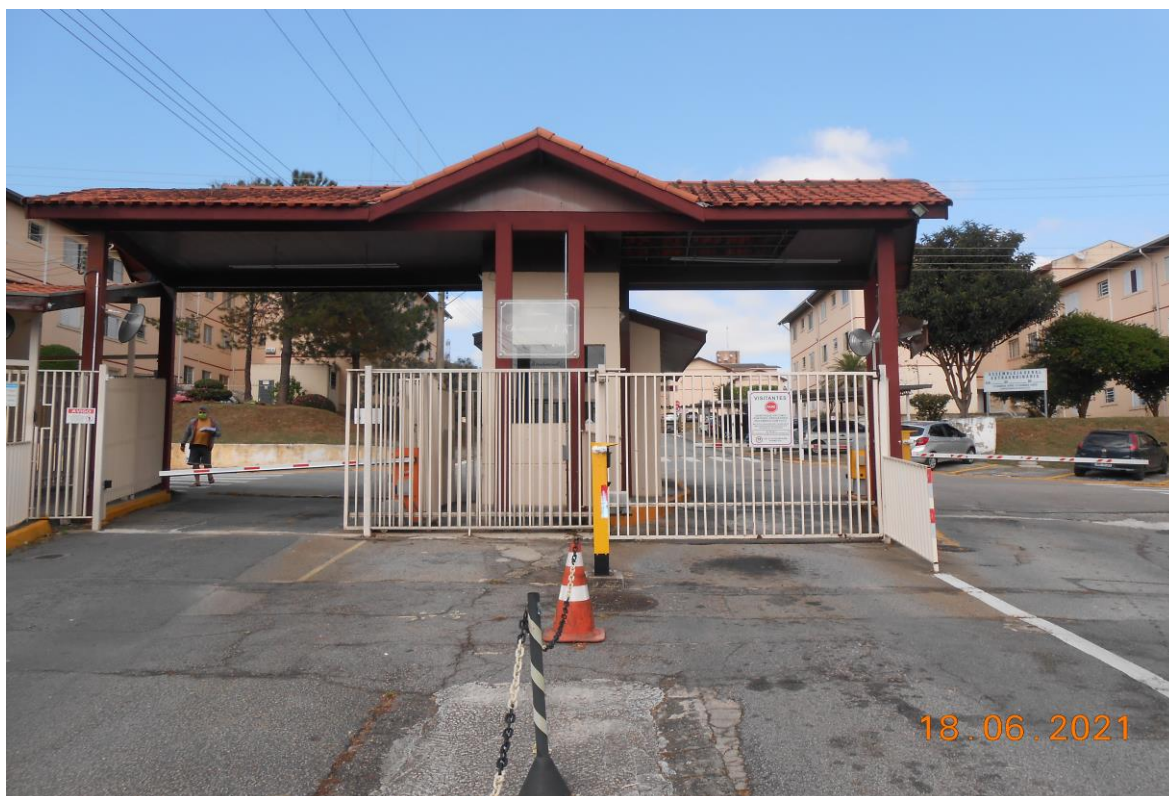
Foto 1: Vista frontal do condomínio.
