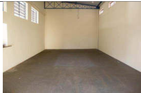
Figura 21 – Salão 02 com piso cimentado
