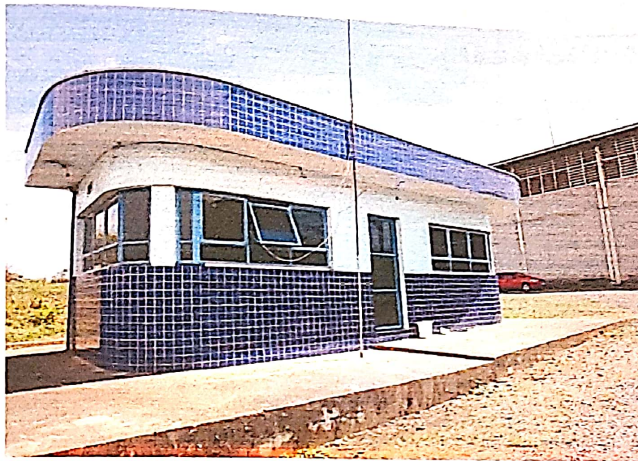
Foto 02: Vista detalhada da Portaria observando suas características construtivas.
