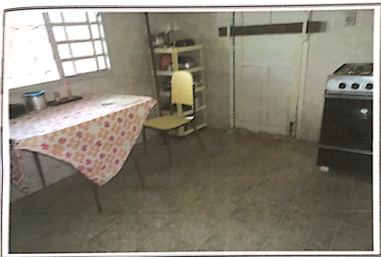
Foto nº 20: Vista da cozinha. Suas principais características construtivas são: piso cerâmico, paredes azulejadas até o teto, forro em laje e esquadrias de ferro.
