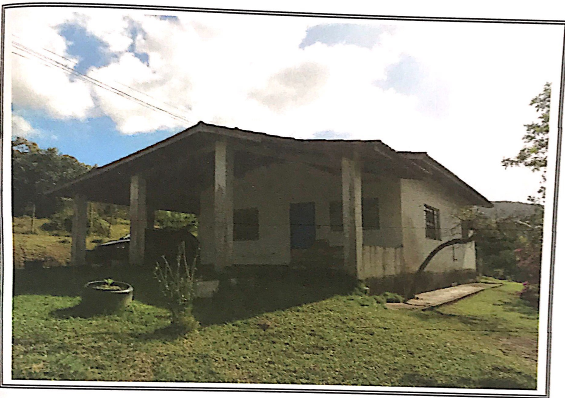
Foto nº 09: Vista da benfeitoria existente no interior do imóvel.
