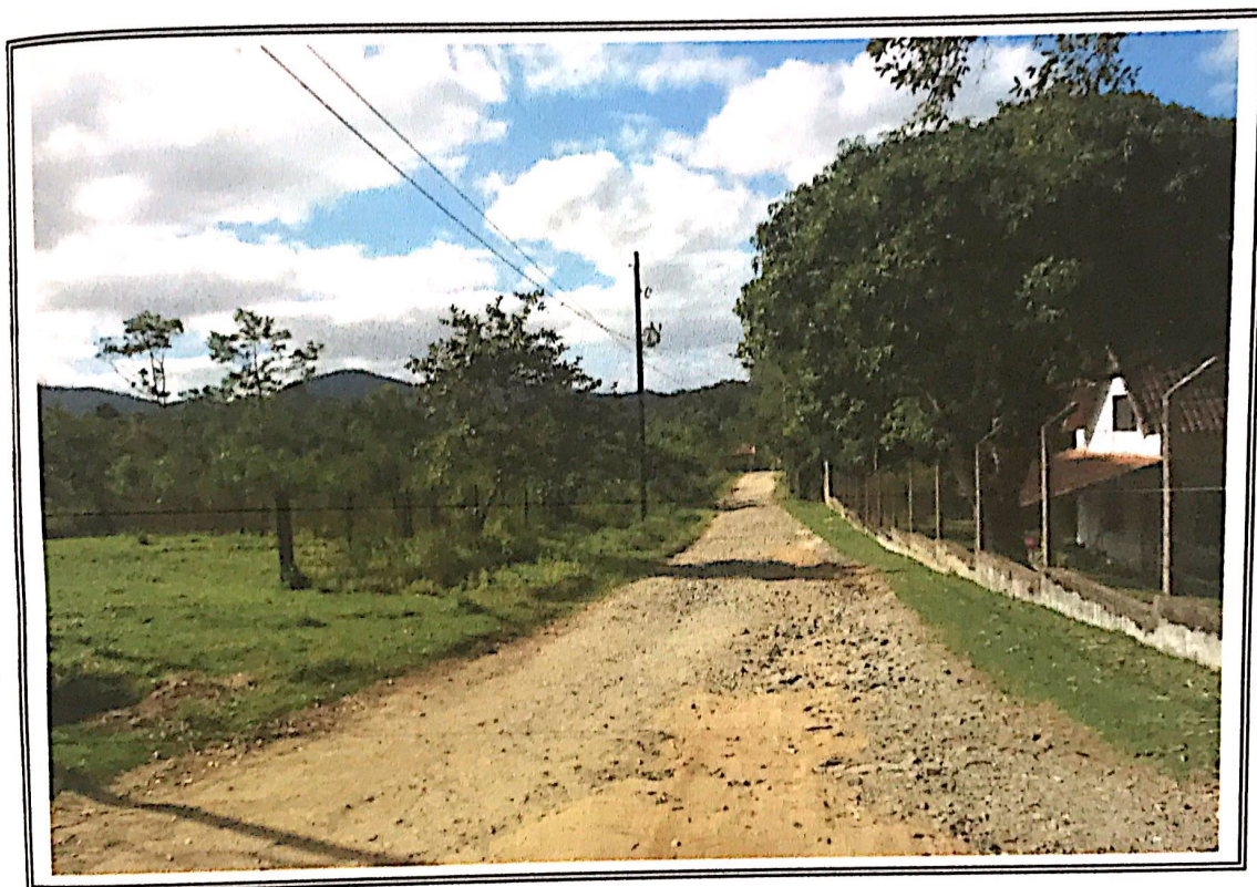
Foto nº 02: Outra vista da Rua 22. O observador encontra-se no mesmo local da foto anterior, dessa vez olhando em direção oposta.
