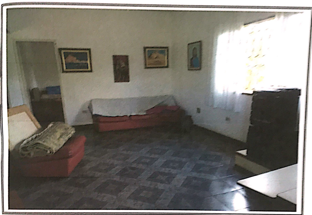
Foto nº 15: Vista da sala. Suas principais características construtivas são: piso cerâmico, paredes revestidas em massa pintadas em látex, forro em laje e esquadrias de ferro.
