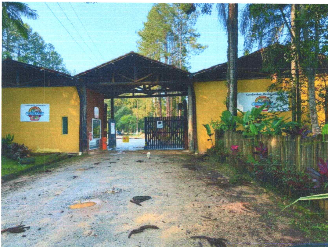
Portaria de Acesso.
