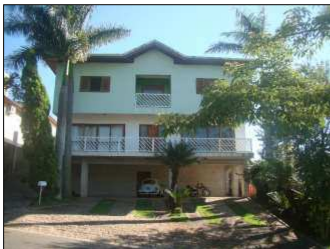
Fotografia 19: Fachada do imóvel
