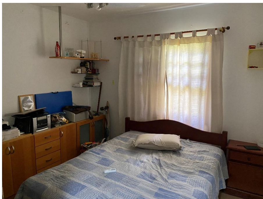
Foto 12 – Vista geral do dormitório II, observando suas características gerais, bem como seu estado de conservação.
