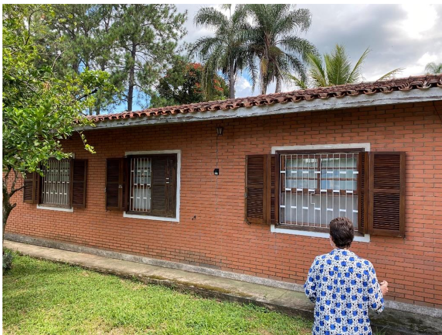
Foto 6 – Outra vista externa da edificação, observando suas características gerais, bem como, seu acabamento e estado de conservação.
