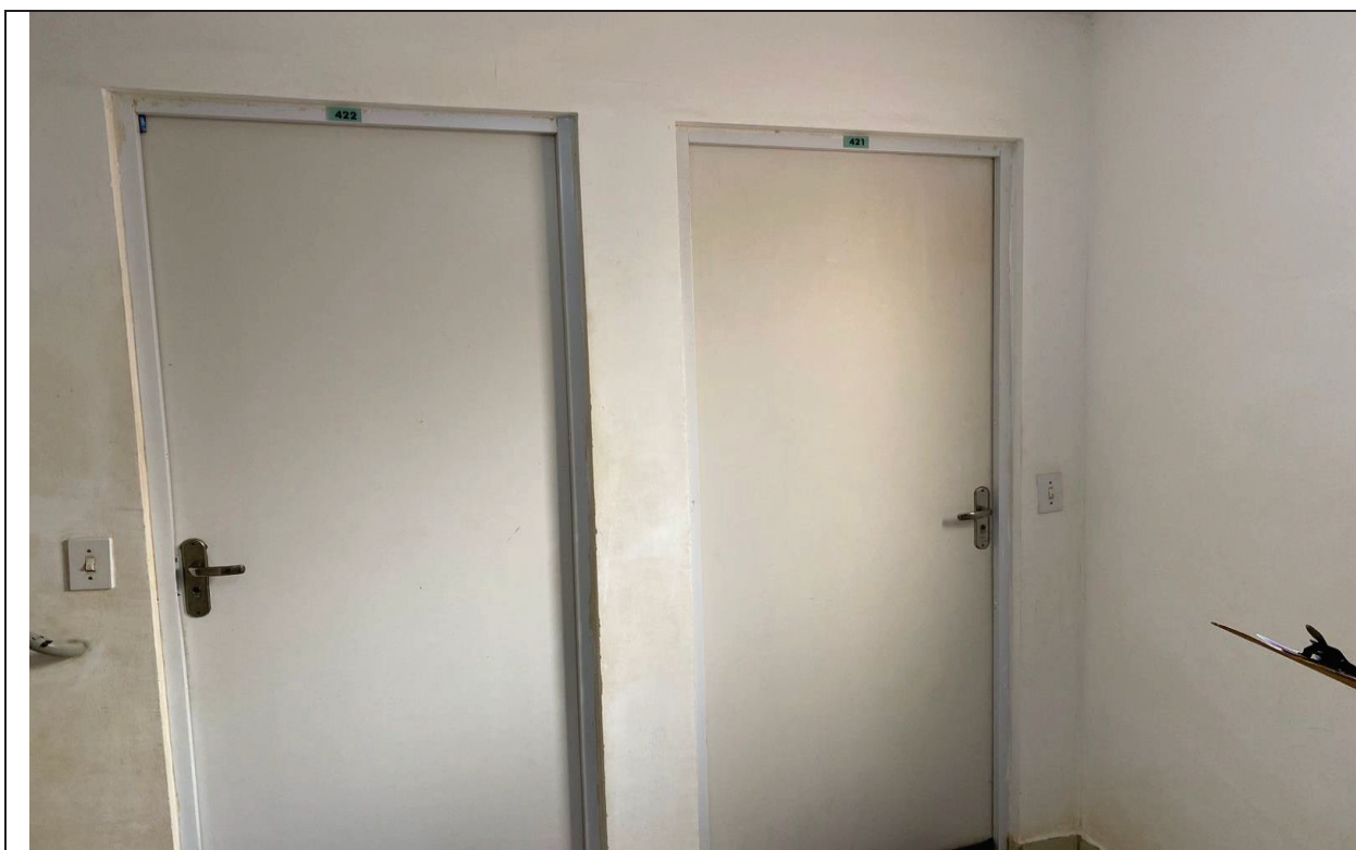
Foto 4: Vista da porta de entrada do imóvel.
