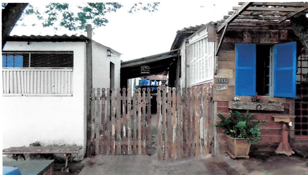
Vista frontal do imóvel avaliando
