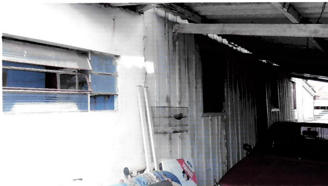
Vista parcial interna do imóvel avaliando
