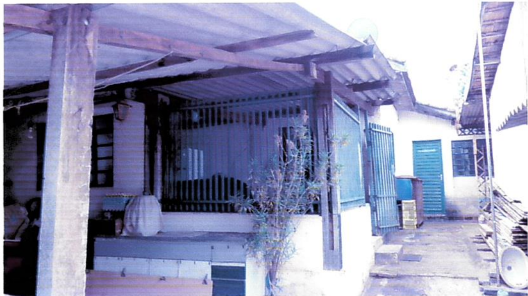
Vista parcial interna do imóvel avaliando
