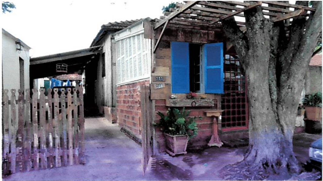
Vista frontal do imóvel avaliando
