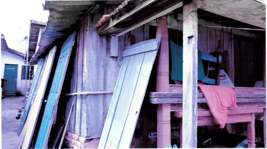
Vista parcial interna do imóvel avaliando
