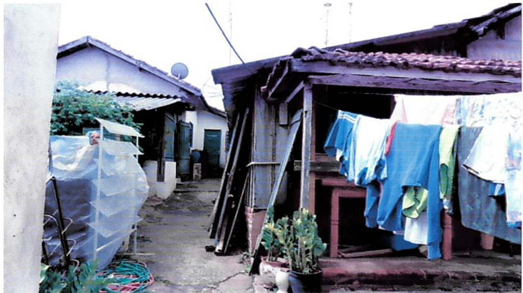
Vista parcial interna do imóvel avaliando
