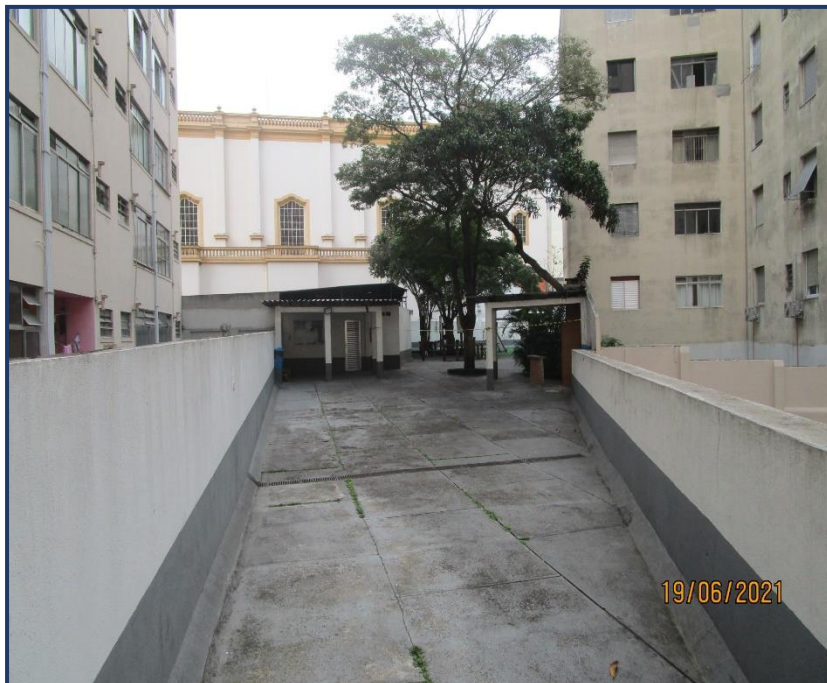
Foto n° 8: Vista geral da área de lazer do edifício.
