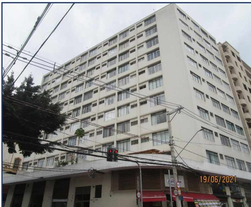
Foto n° 2: Outra vista do Edifício Itororó.
