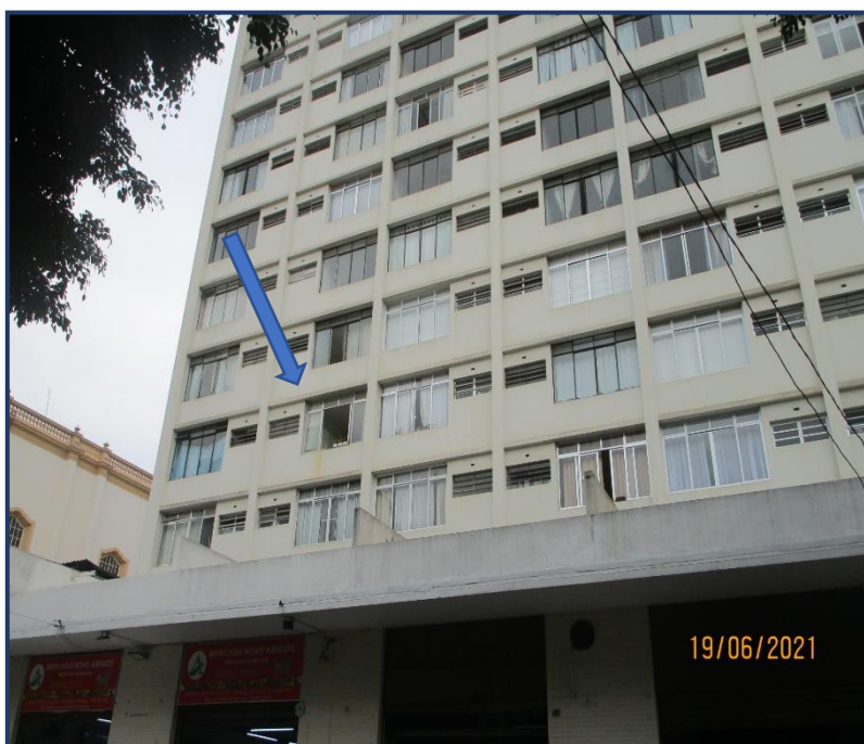
Foto n° 19: Detalhe para a fachada do imóvel voltada para a Rua Martiniano de Carvalho.
