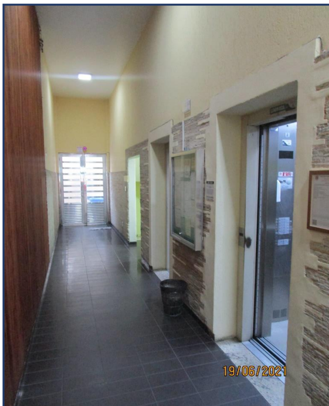
Foto nº 5: Vista geral do hall social de elevadores.
