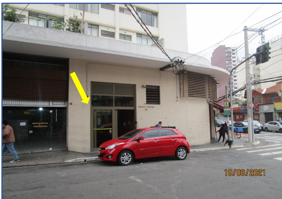
Foto: Vista geral da entrada principal do Edifício Itororó.
