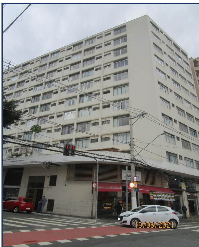
Foto n° 1: Vista geral do Edifício Itororó.
