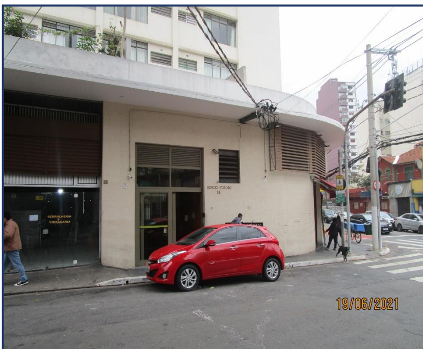
Foto n° 3: Vista geral da entrada principal do condomínio.
