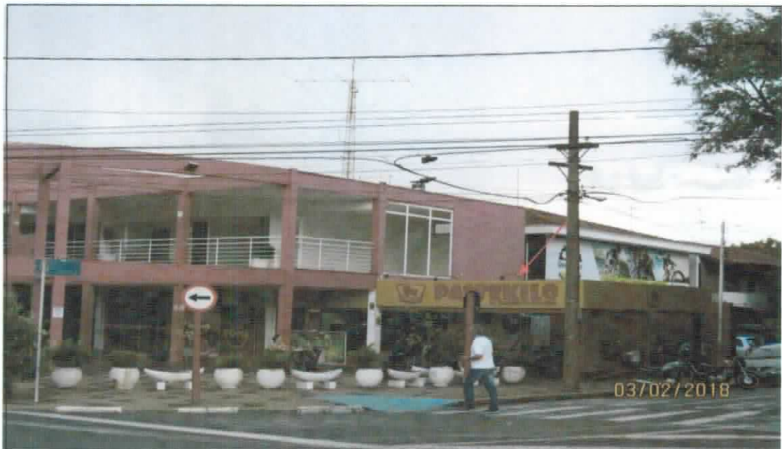
FOTO 07 – VISTA DE LOJA QUE ALTERA A FORMA DA FACHADA DO EDIFÍCIO
