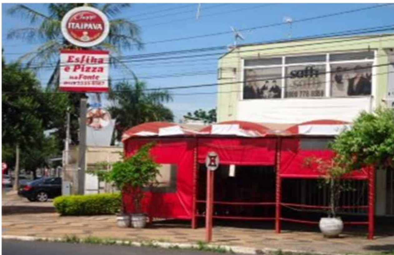
Foto 8: Instalação de TOTEM da Itaipava em ÁREA COMUM e fachada do Center Fonte (que foi inutilizada pela LOJA 01).
