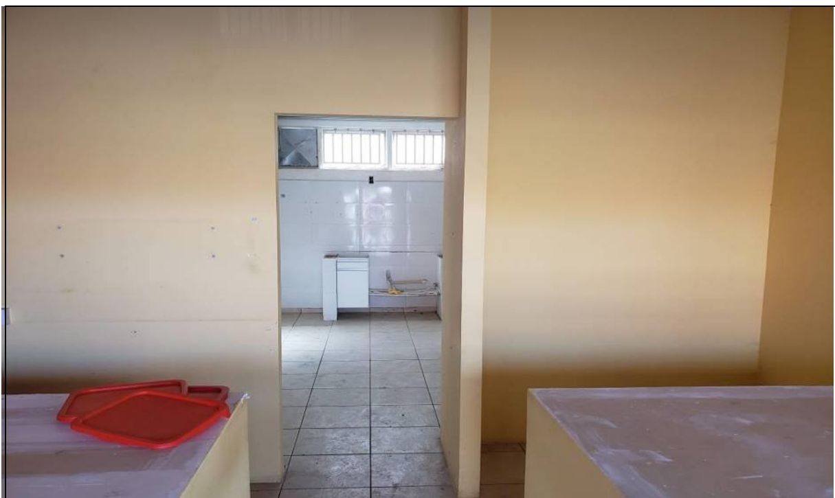
FOTO 03 – Vista interna da sala nº07 no empreendimento Center Fonte
