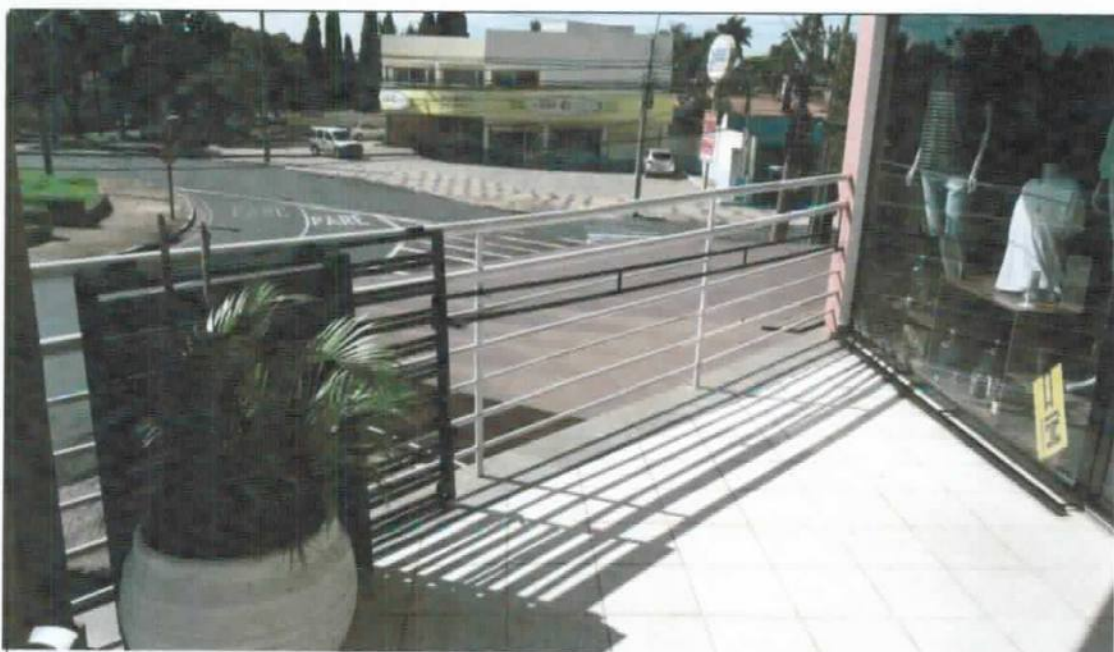
FOTO 12 – VISTA DE GRADIL METÁLICO NA PARTE EXTERNA DE UMAS DAS LOJAS EM ÁREA COMUM DO EDIFÍCIO.
