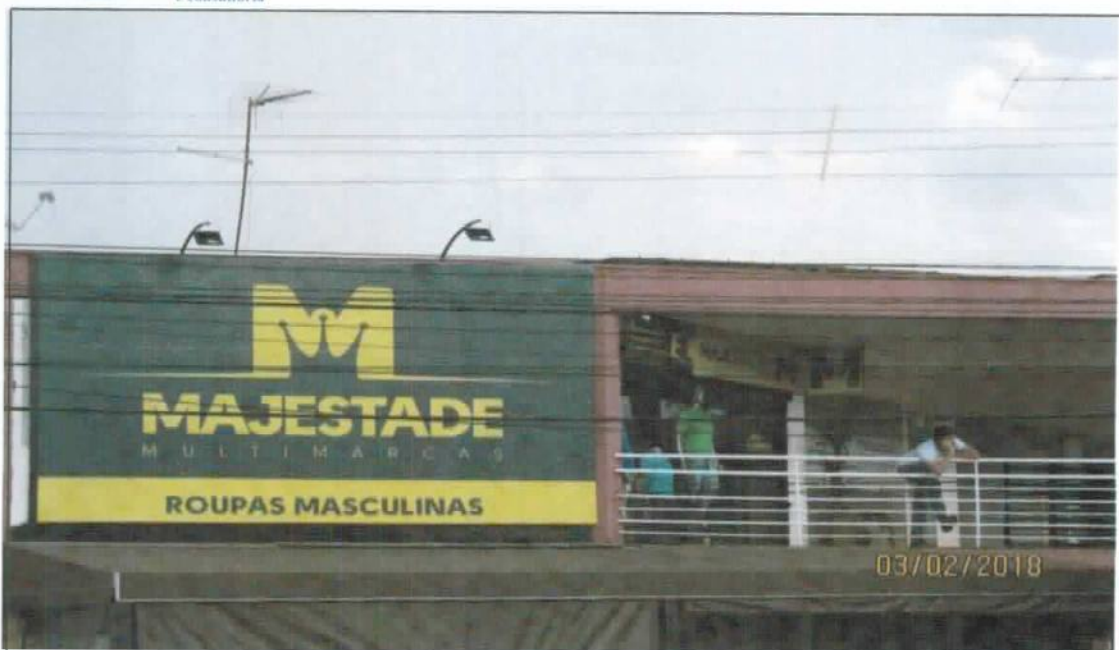
FOTO 09 – VISTA DE LOJA QUE ALTERA A FORMA DA FACHADA DO EDIFÍCIO
