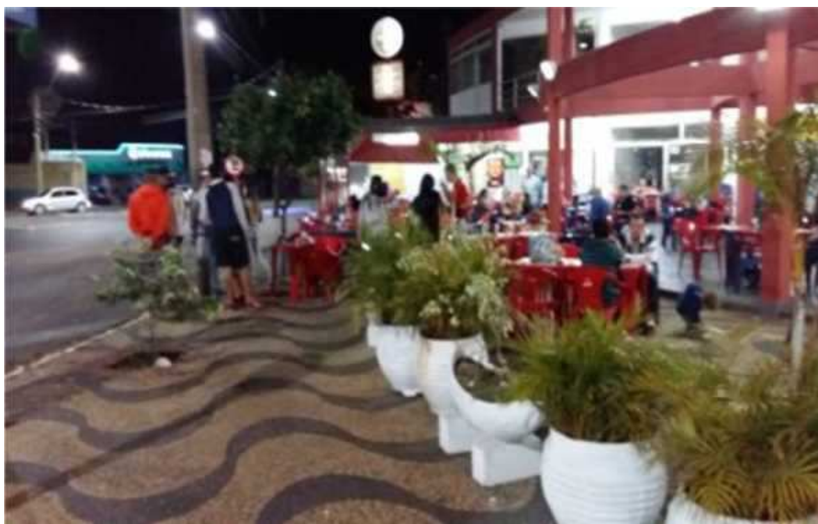
Foto 3: total desrespeito aos cidadãos com mobilidade reduzida e cadeirantes, com o deliberado e irresponsável fechamento da calçada pela LOJA 01.
