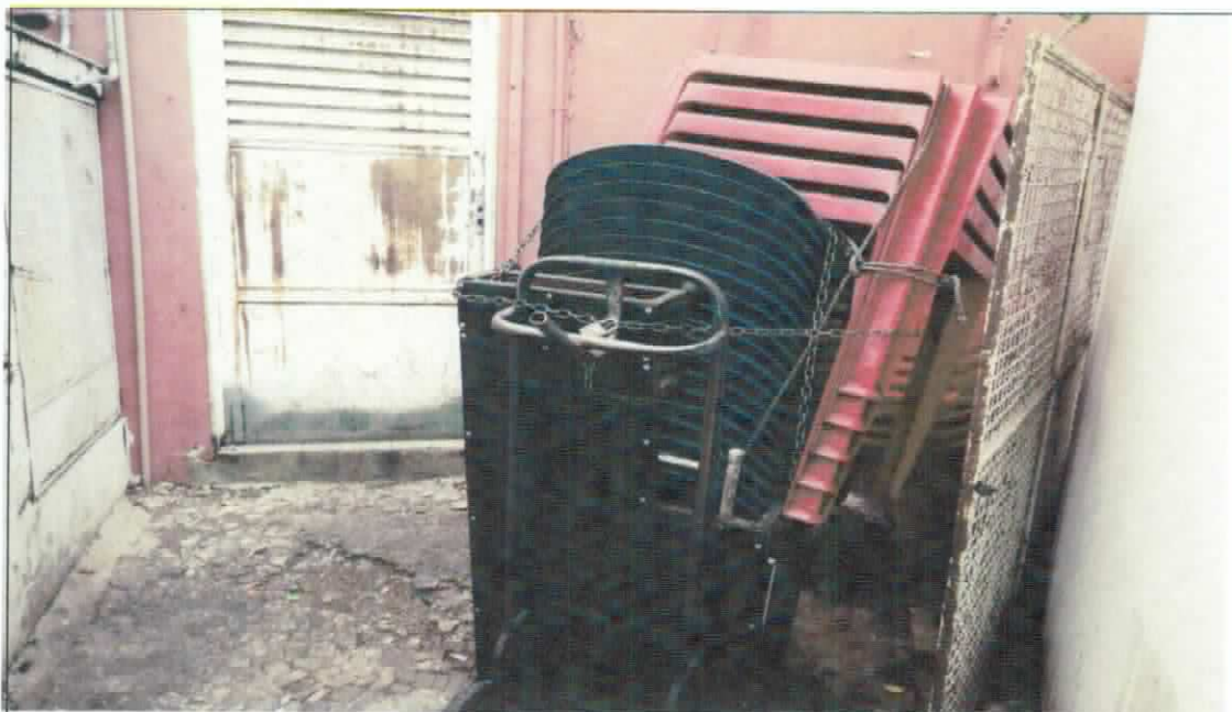
FOTO 05 – VISTA DA PARTE DE FUNDOS DO EDIFÍCIO OCUPADA COMO DEPÓSITO POR MESAS E CADEIRAS.
